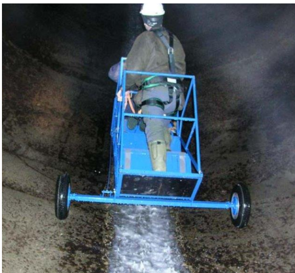
Figur 3 Inspektionsvagn för inspektion av lutande tilloppstub.
