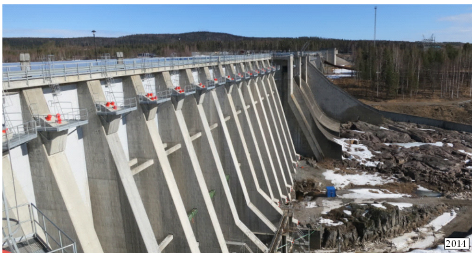
Figur 67. En tunn lamelldamm byggdes vid Storfinnforsens kraftverk 1949–1954. Foto M Rosenqvist.
