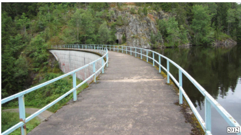
Figur 71. En av landets första valvdammar byggdes vid Klinte kraftverk 1908–1910. Foto Y Helmfrid Schwartz.
