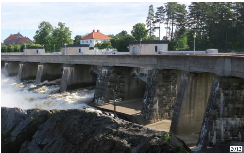
Figur 26. Tre stembeklädda pelare i den nya storfallsdammen vid Älvkarleby kraftverk. Foto M Rosenqvist.
