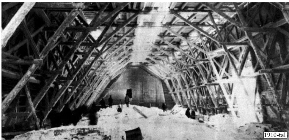
Figur 34. Varmskjul för att skydda betongen från frysning i samband med gjutningarna av skibordsdammen vid Porjus kraftverk. Fotografiet från [117].
