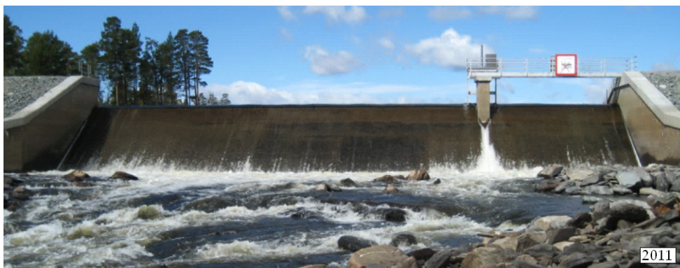
Figur 53. Överfallsdamm av betong för automatisk reglering av Ljusnedalssjön. Foto M Rosenqvist.
