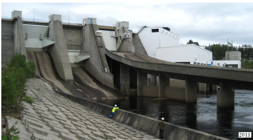
Figur 13. Försök att i en ledmursmonolit ersätta en del av LH-cementet med trass genomfördes i samband med Tuggens kraftverksutbyggnad 1957–1962. Foto M Rosenqvist.
