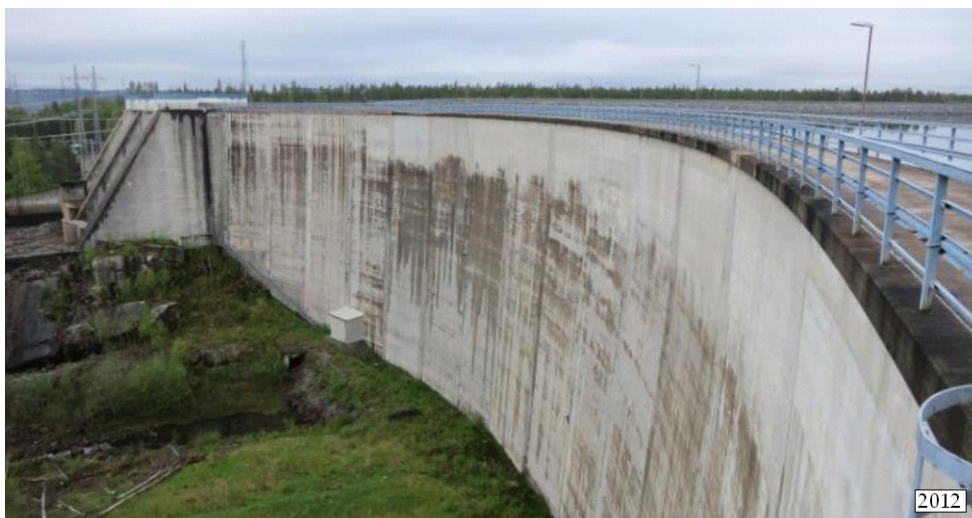
Figur 75. Valvdammen som uppfördes vid Vargfors kraftverk under åren 1958–1961. Foto M Rosenqvist.
