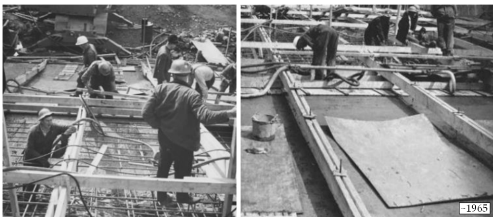
Figur 37. Samtliga skibordsytor och strålllyftare i utskovspartiet vakuumbehandlades i samband med Moforsens kraftverksbygge 1964–1967. Foto Uniper via C-O Nilsson.
