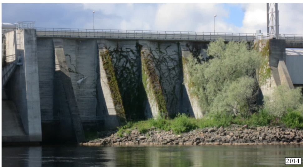
Figur 66. Nedströmsvy över fem monoliter till den tunna lamelldammen som byggdes vid Ljusne Strömmars kraftverk mellan åren 1946 och 1949. Foto M Rosenqvist.
