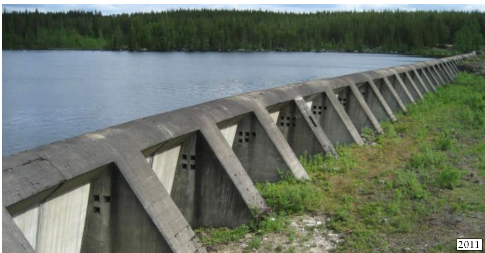
Figur 8. Grov lamelldamm vid Betsele kraftverk. Provgjutning med Gullhögen LH-cement genomfördes i två av dammens monoliter. I övriga monoliter användes Limhamn LH-cement. Foto M Rosenqvist.
