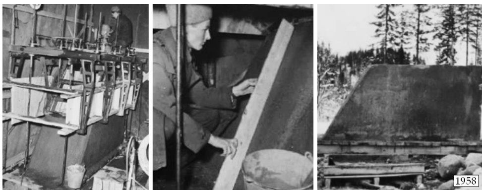
Figur 30. Provgjutning med glidform av stöpelare med lutande sida vid kraftverksbygget i Pors (t.v.). I mitten kontrollmätning av den lutande ytan. Stöpelaren efter avslutat arbete (t.h.). Foton från [11] (opublicerad).
