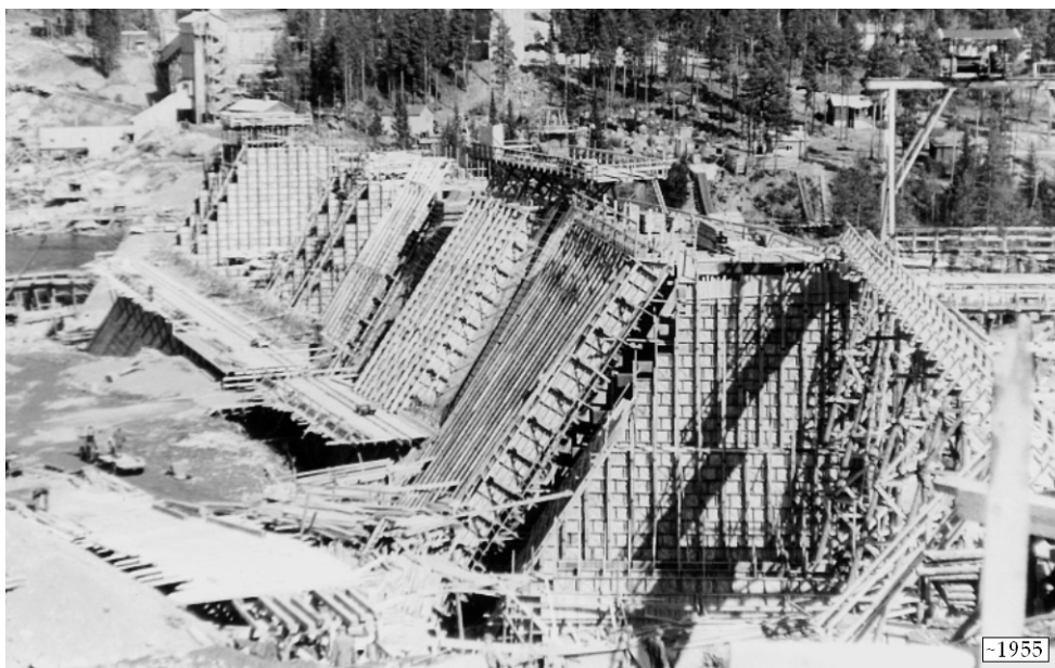
Figur 29. Vid kraftverksbygget i Ramsele 1954–1958 användes standardiserade formluckor i formbyggnaderna till lamelldammens stödpelare. Foto Uniper via C-O Nilsson.
