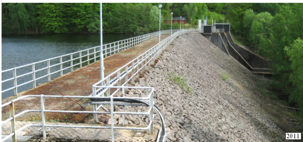
Figur 89. En stenfyllningsdamm med frontplatta av kraftigt armerad betong byggdes vid Nissaström kraftverk mellan åren 1947 och 1950. Foto M Rosenqvist.
