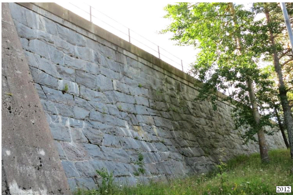
Figur 48. Stenmurverksdamm vid Älvkarleby kraftverk. Foto M Rosenqvist.
