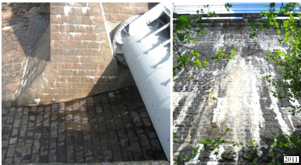
Figur 25. Storsten i ett skibord till Karsefors damm (t.v.) och nubbsten på nedströmssidan av dammen vid Knäred Övre (t.h.). Foto M Rosenqvist.
