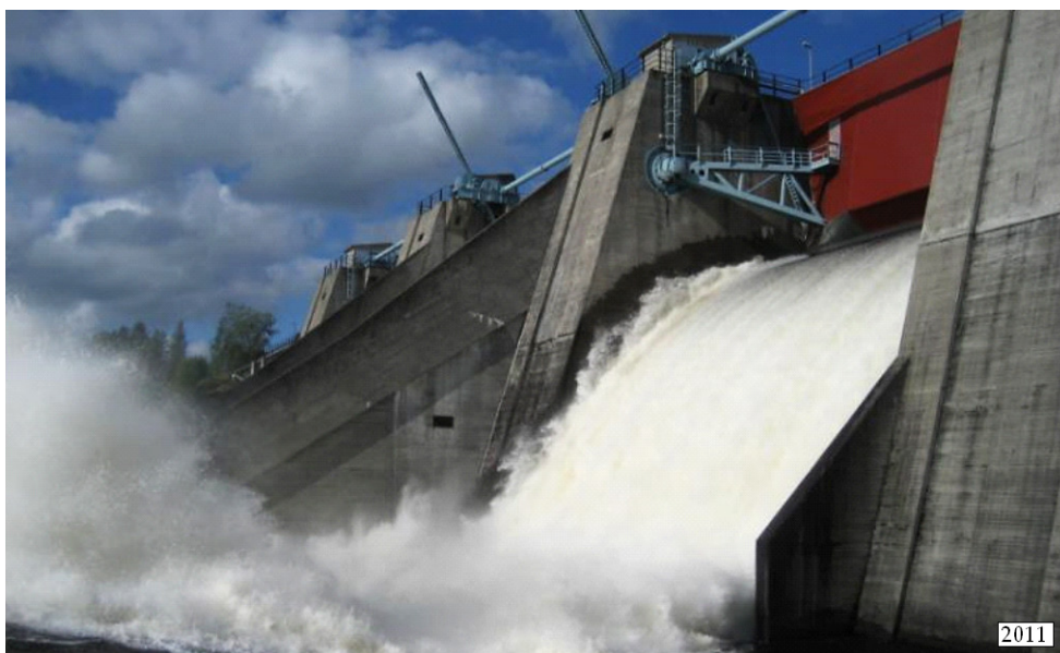
Figur 45. Tappning av vatten vid Bålforsens kraftverk. Hastigt strömmande vatten kan vara en bakomliggande anledning till erosionsskador på betong i exempelvis utskovskonstruktioner. Foto M Rosenqvist.
