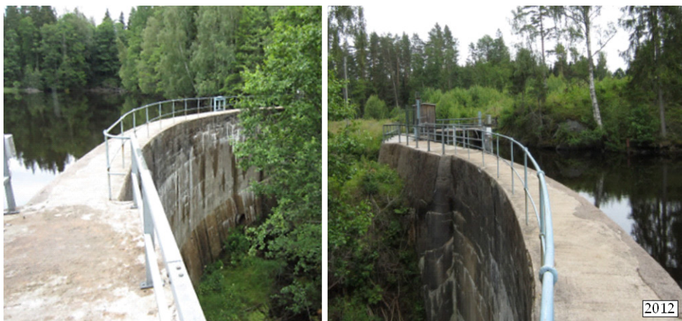
Figur 72. Valvdammen som byggdes vid Brunnshtults kraftverk 1908–1910. Foto Y Helmfrid Schwartz.
