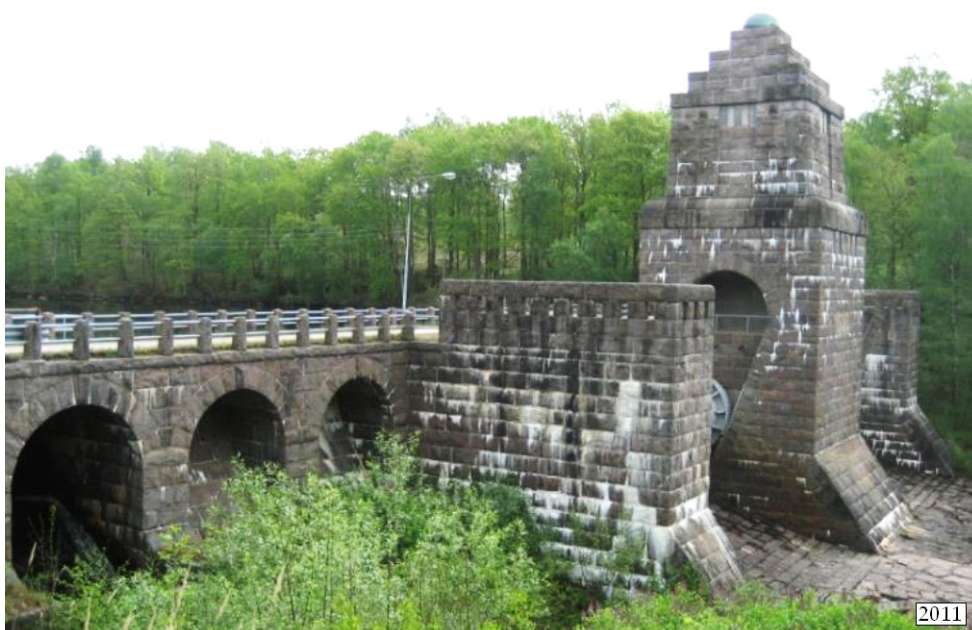
Figur 24. Stenbklädd betongdamm vid Karsefors kraftverk. Foto M Rosenqvist.
