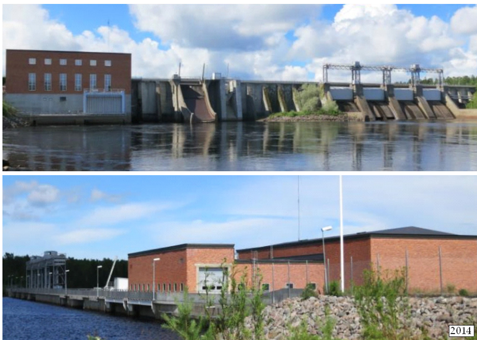
Figur 7. Uppströms- och nedströmsvy av maskinhus, lamelldamm och utskovsparti vid Ljusne Strömmar. Under dammbyggnadsarbetet genomfördes provgjutning med Limhamn LH-cement i en monolit. Foto M Rosenqvist.
