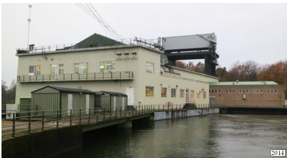
Figur 5. Maskinhus och utskovsparti vid Vargöns kraftverk. Silikatcement (sedermera Limhamn LH-cement) kom till användning för första gången vid Vargöns kraftverksutbyggnad 1932–1934. Foto M Rosenqvist.
