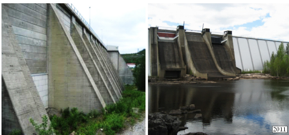
Figur 69. Betongdammar av typen tunn lamelldamm uppfördes vid kraftverken i Tuggen åren 1957–1962 (t.v.) samt i Rätan åren 1964–1968 (t.h.). Foto M Rosenqvist.
