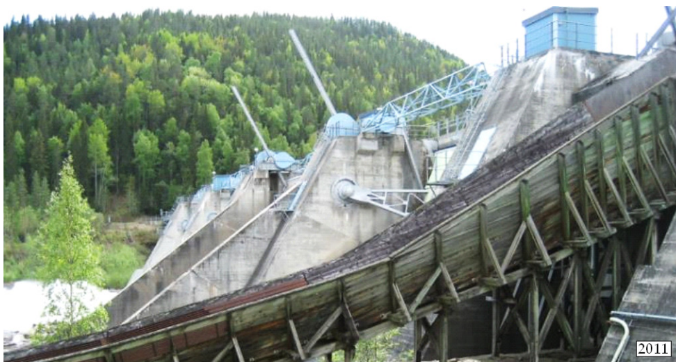
Figur 10. Pansar silikatcement användes i regleringsdammen vid Krångede kraftverk. Foto M Rosenqvist.
