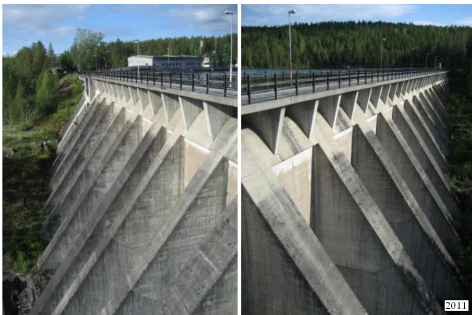
Figur 61. En grov lamelldamm uppfördes vid Bålforsens kraftverk 1954–1958. Foto M Rosenqvist.
