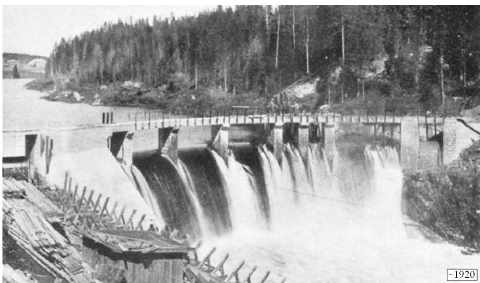
Figur 73. Valvdammen som byggdes vid Gideåbacka kraftverk 1916–1918. Bilden från [137].
