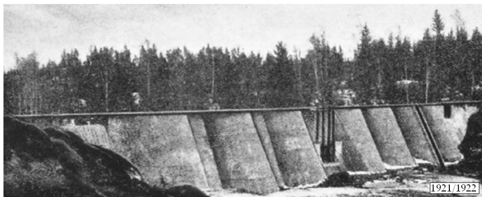
Figur 77. Sveriges första serievalvsdamm byggdes vid Melby kraftverk 1921–1922. På fotografiet syns dammen innan den första dämningen. Fotografiet från [137].
