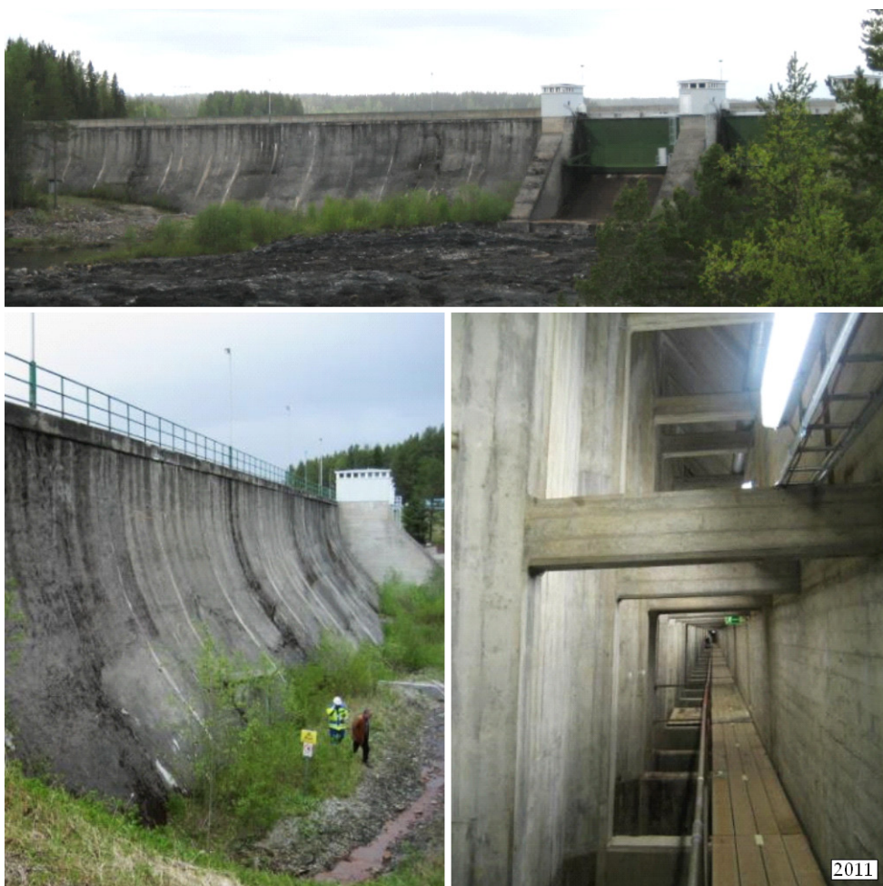
Figur 57. Regleringsdammen vid Kattstrudeforsens kraftverk. Frontplattan av armerad betong bärs upp av otaliga stöttor som vilar på den bakomstående massiva dammkroppen. Foto M Rosenqvist.
