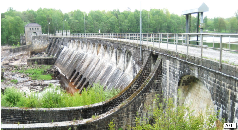
Figur 50. Massivdamm av betong vid Skogaby kraftverk (1919–1922). Foto M Rosenqvist.
