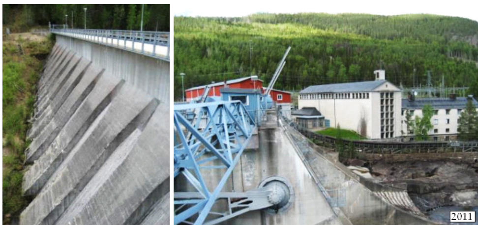
Figur 59. En grov lamelldamm uppfördes vid Krångede kraftverk 1933–1936. Foto M Rosenqvist.
