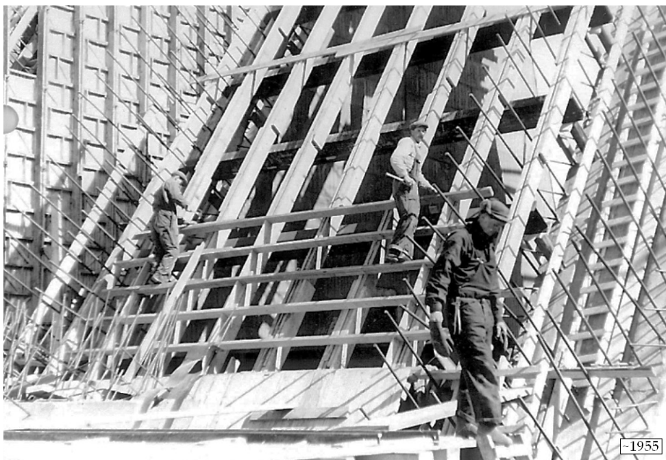
Figur 27. Pågående formbyggnadsarbete vid lamelldammen under Ramsele kraftverksutbyggnad 1954–1958. Foto Uniper via C-O Nilsson.
