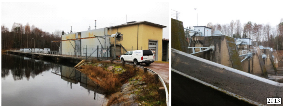
Figur 9. Slaggcement användes för första gången i större omfattning inom svensk vattenkraft i samband med Lindbyns kraftverksutbyggnad 1951–1954. Foto M Rosenqvist.
