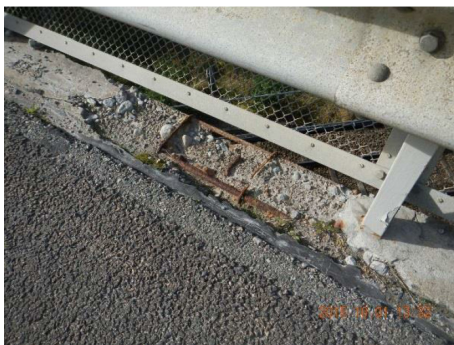
Kantbalk (ovansida) – spjälkning, armeringskorrosion
