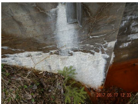
Betong – urlakning
