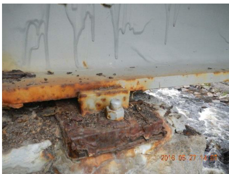
Lager – korrosion
