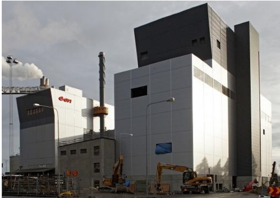
Figure 2. The waste incinerator plant P15 at Händelöverket
