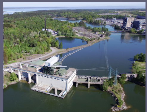
Kraftverk i Göta älv. Foto: Norconsult
