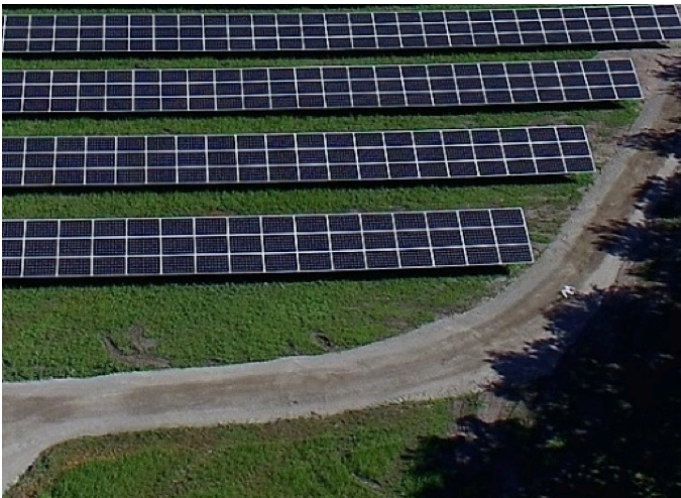
Solceller i Varberg placerade med avstånd till träd, och avstånd mellan rader för att minimera inverkan från skuggning.
