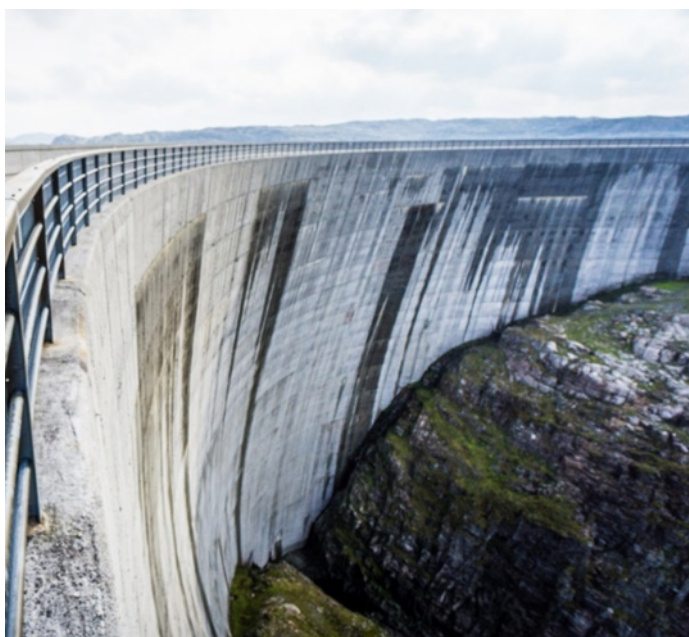
Figur 22: Førevassdammen 2016, Norge. ( http://www.xn--nnas-poa.no/wp-content/uploads/2016/09/DSC4724-2736x1530.jpg )
