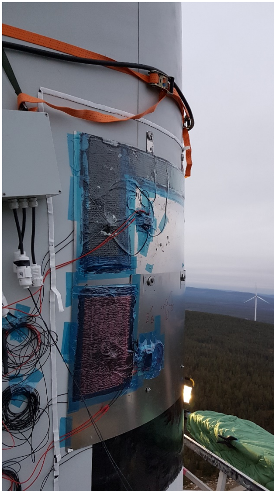
Figur: Montage av värmemodul på blad
