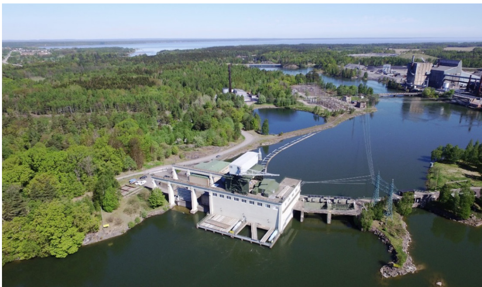
Figur 9. Vargöns kraftstation, strax nedströms Vänerns utlopp i Göta älv (överst i bild).
