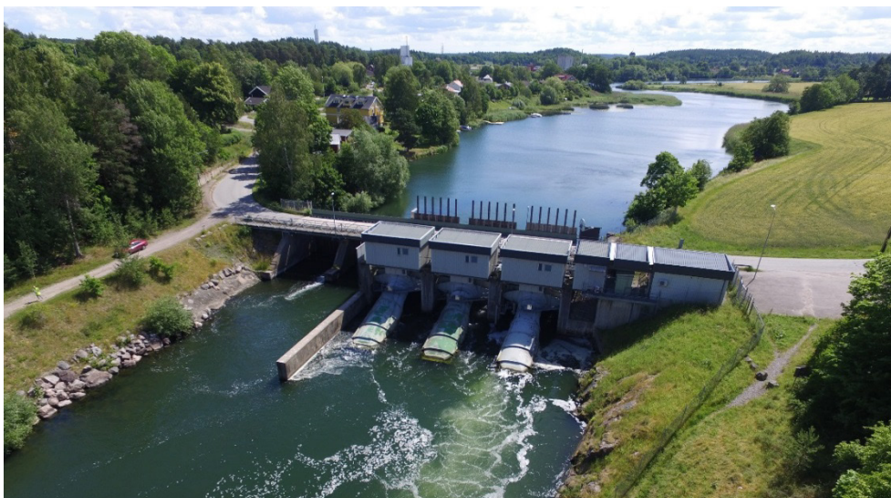
Figur 1. Älvås kraftverk. Vy från nedströmssidan. Norconsult 2016.
