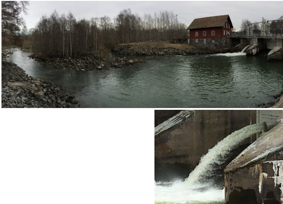
Figur 14. Översiktsbild på utskov vid Skärblacka kraftverk (övre panelen) samt detaljbild av rör (nedre panelen) för kontinuerligt spill ( 0,5\text{m}^3/\text{s} ) genom omlöp (naturfåran).
