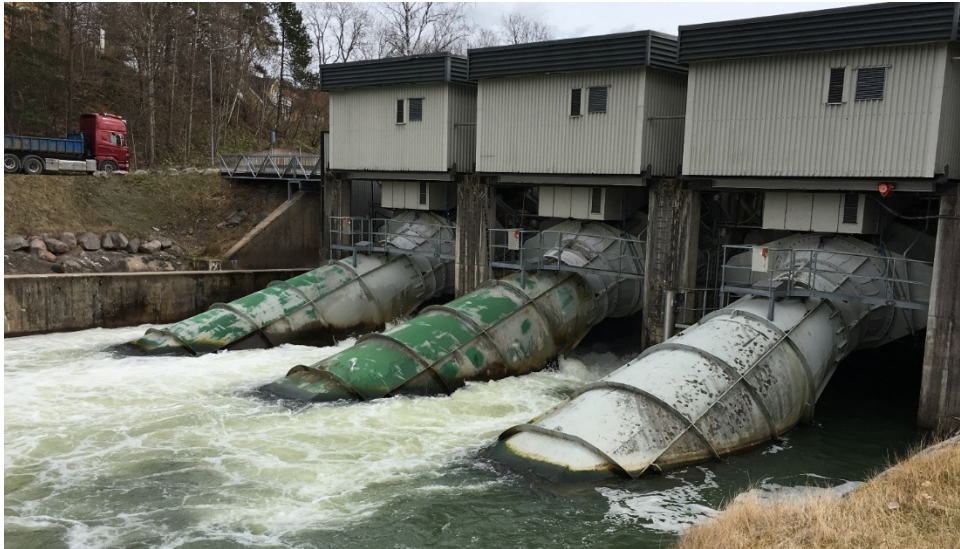
Figur 13. Nedströms vy av kraftstationen vid Älvås. Vid detta tillfälle är ingen av turbinerna i drift och vatten spills under de två längst bort.
