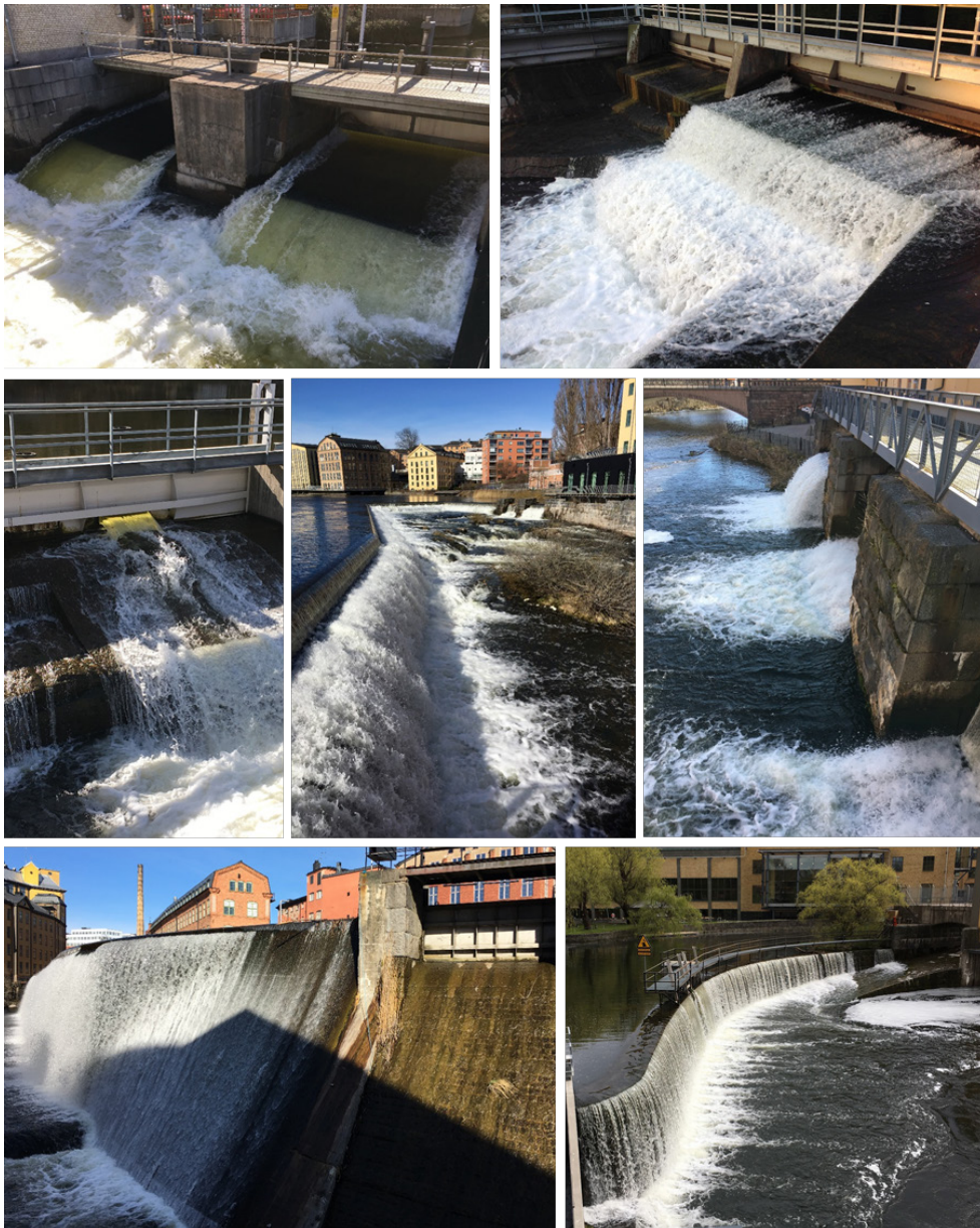
Figur 15. Vattnets väg genom Norrköping. Vid Grytsdammen spills vatten genom luckor av varierande storlek (övre panelen och mittpanel, vänster), sedan går vattnet över Bergsbrodammen (mitten) eller genom luckor i sydöstra änden av denna (mittpanel, höger) och vidare antingen genom luckor i stora dammen (ej på bild) eller över Södra dammen (nedre panelen, vänster), och till sist över Hästskodammen (nedre panelen, höger). Vid höga flöden öppnas en lucka i västra änden av Södra dammen, direkt ner förbi Hästskodammen (skymtas i högra änden av bilden på Hästskodammen)
