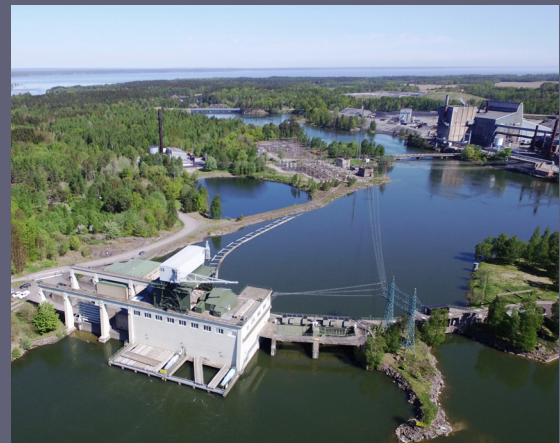
Kraftverk i Göta älv. Foto: Norconsult
