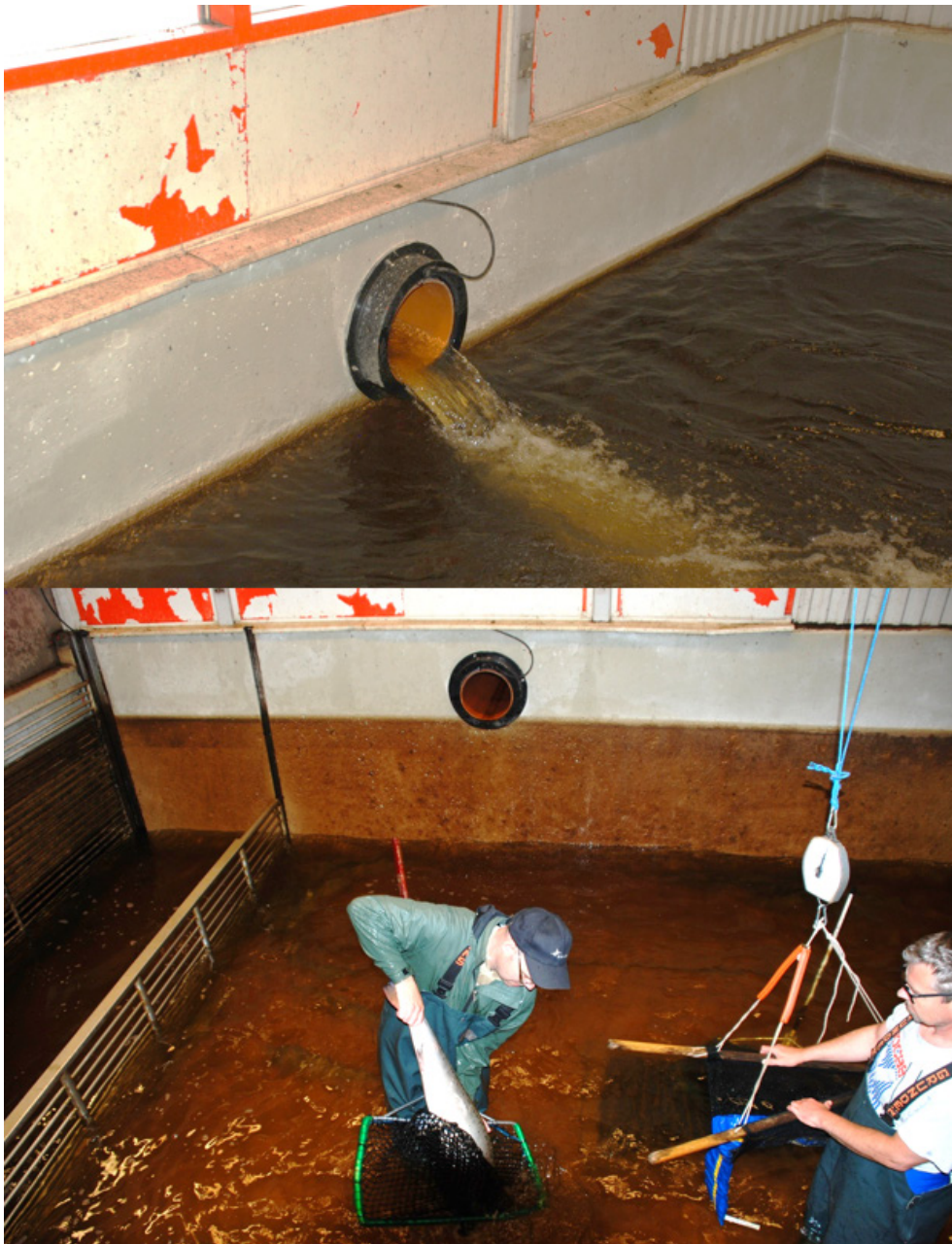
Bild 2. Den övre bilden visar transportröret från fångstanläggningen i Dalälvens centralfiske till bassängen där fisken skannas efter PIT-tags, vägs och mäts. Notera PIT-tag antennen utanpå röret. Nedre bilden visar fångst och hantering av fisk (Foto: Jörgen Rask).
