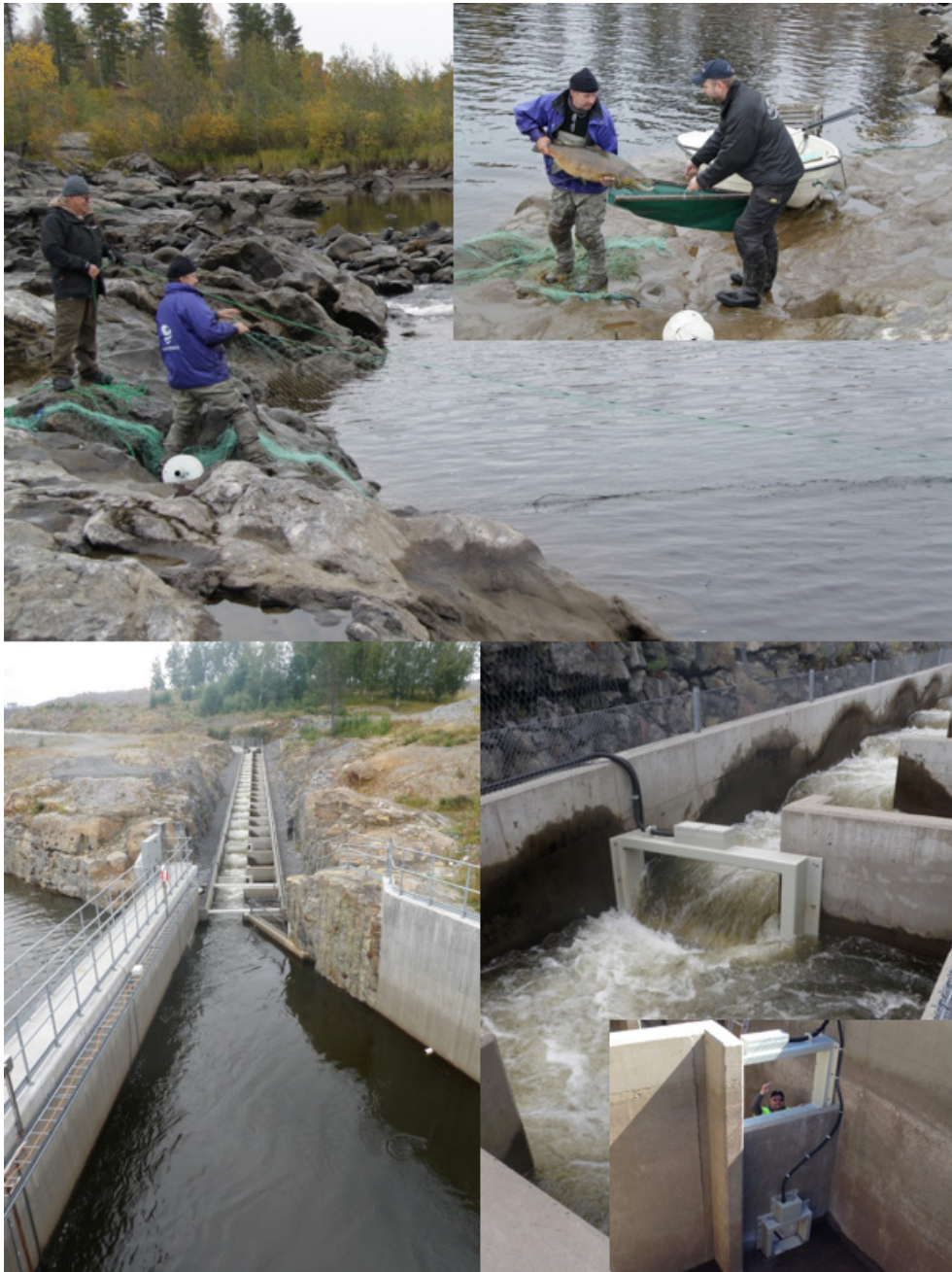
Bild 1. De övre bilderna visar nätfiske efter lekmogen lax nedanför Stornorrfors damm, det så kallade poolfisket. All fisk skannas efter PIT-tags (Foto: Anders Alanärä). De nedre bilderna visar laxtrappan i Stornorrfors. Till vänster den så kallade diffusorn där fisk ansamlas innan de vandrar upp i trappan och till höger bilder på PIT-tag antennerna i trappan (Foto: Anders Alanärä).
