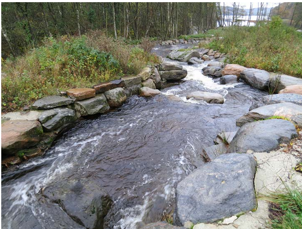
Figur 17. Den naturliga fiskvägen vid Älgårda ligger vid sidan om kraftverket.
