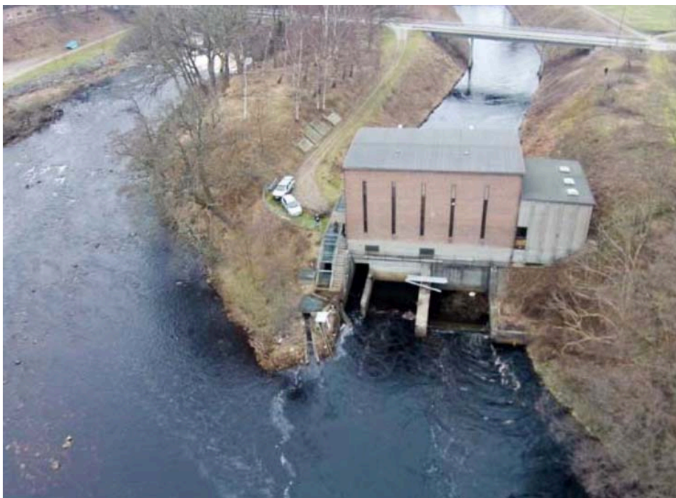
Figur 11. Fiskvägen vid Slottsmöllan i Nissan är belägen intill kraftverkets utlopp på den vänstra sidan sett nerifrån.
