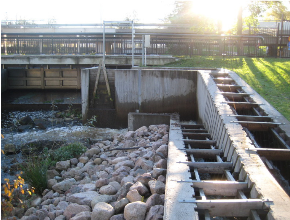
Figur 5. Fiskvägen vid Elverksdammen i Svartån gör det möjligt för vandrande fisk att passera dammen.
