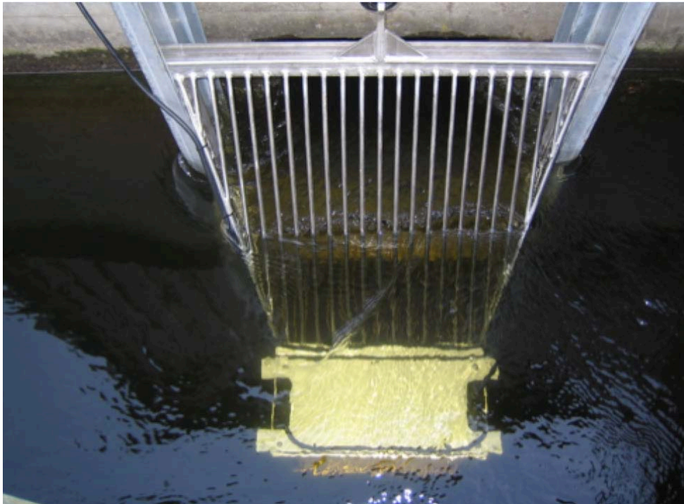
Figur 21. Vaki RW fiskräknare med gallergrindar, vy uppifrån ner mot fiskräknaren vid Jonsered (övre).
