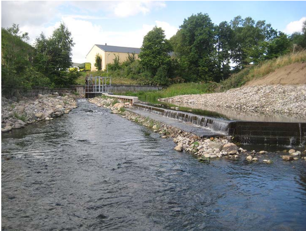
Figur 8. I samband med att fiskvägen vid Köpingsbro byggdes skapades fria vandringsvägar för fisk av alla arter och storlekar.
