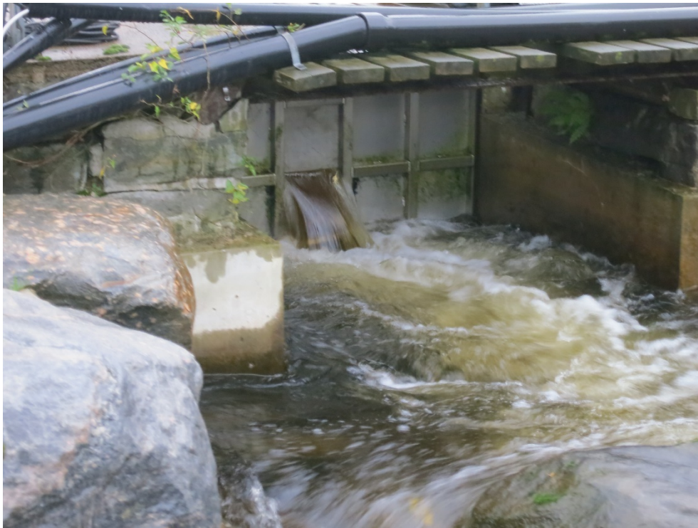
Figur 24. Inloppet till omlöpet vid Ålgårda i Rolfån innebär en svårpasserad tröskel för uppvandrande ål.
