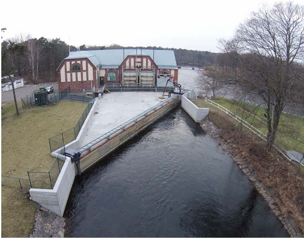
Figur 28. Kraftverket vid Herting i Ätran där intaget är försett med ett fingaller (15 mm), s.k. beta-galler med flyktöppning för fisk placerad längst ner till höger i bild.
