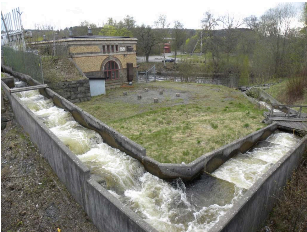
Figur 22. Fiskvägen vid Jonered (nedre) ligger vid sidan om kraftverket, utgörs av en teknisk fiskväg (foto: Per Persson).
