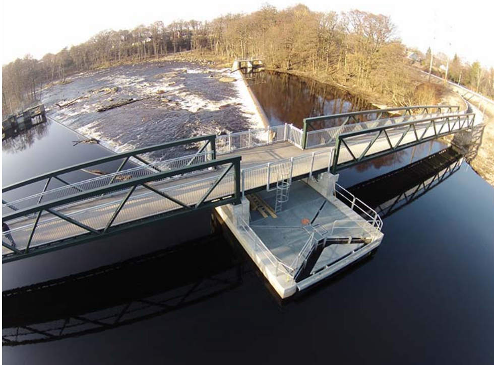
Figur 14. Den nya naturliknande fiskvägen vid Herting ligger i kraftverkets tidigare torrfåra. Fiskvägen möjliggör passage för uppvandrande fisk av alla arter och storlekar.
