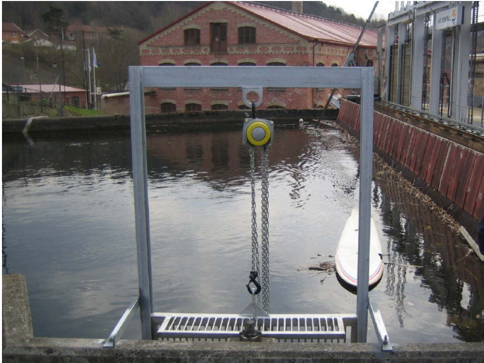
Figur 23. Fiskräknaren var placerad framför inloppet till Jonsered (nedre) fiskväg omedelbart uppströms kraftstationens vattenintag vid inloppskanalens högra sida. Vy från fiskvägen mot söder.
