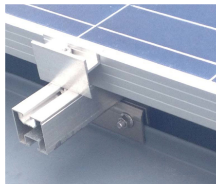
T.v. Infästning på papptak med förstärkning kring infästningen.
