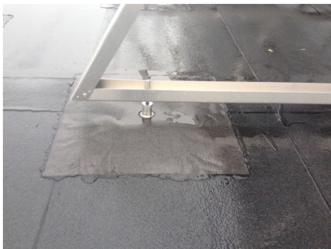
Montage med ballastmetod
