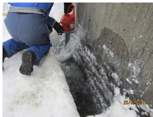
Figur 6-2. Uppsågning av isvak.
