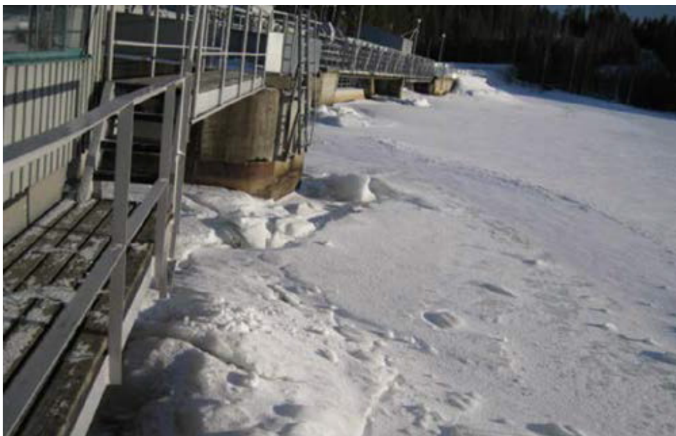
Figur 1-1. Is mot monolit mellan intag och flottningsutskov vid Krångfors kraftstation (Foto: Skellefteå Kraft), från Johansson et al (2013).
