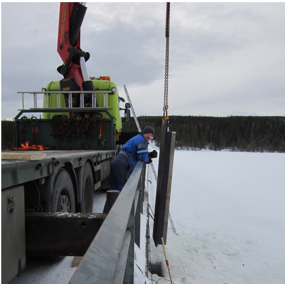
Figur 6-3. Lyft av lastpanel med kranbil.
