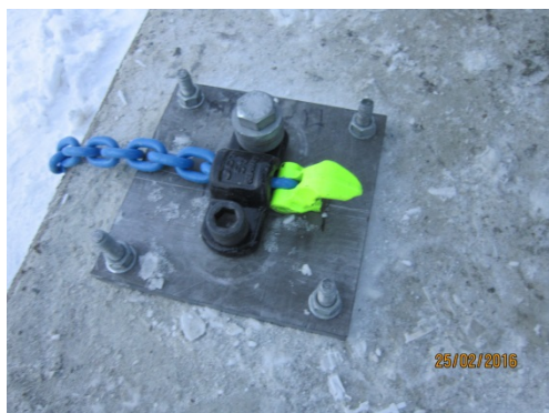
Figur 6-1. Fäste för lyftkätting.
