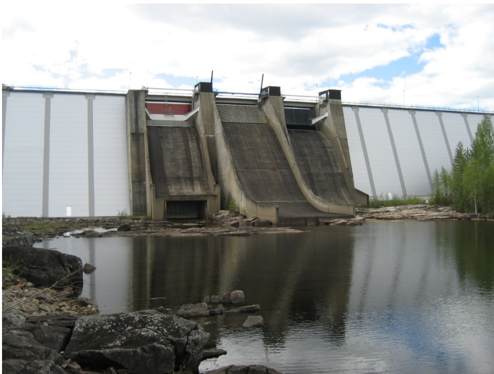
Figur 5-3 Översiktsbild av Rätans dammanläggning från nedströmssidan. Foto: Martin Rosenqvist.
