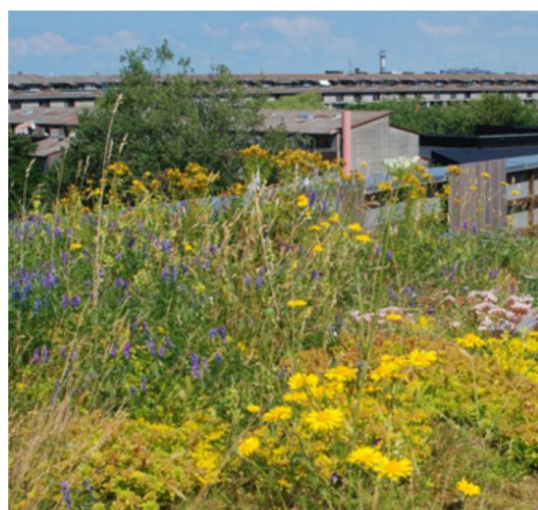
I princip kan alla växter användas på tak, men det gröna takets uppbyggnad måste då anpassas efter växterna. Idag är det vanligast med sedumtak och sedum-ört-tak. Sedumtak består oftast av sedum- och mossarter. Sedum-ört-tak är vanligen semi-intensiva tak som har ett mer ängsliknande utseende än sedumtak. De innehåller vanligen en blandad vegetation av sedum, torktåliga örter och gräs. Bilden ovan visar ett exempel på ett sedum-ört-tak. Bilderna på föregående sida visar ett sedumtak.
