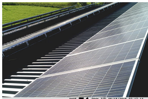
Figur 5. Anläggning Bleka rader
