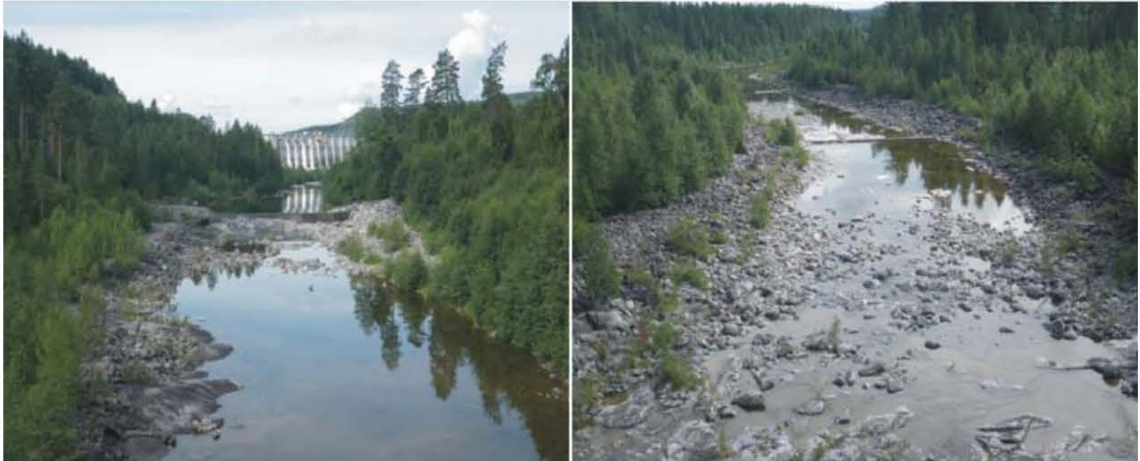
Figur 47. Fotografier av grunddammarna i torrfårans övre del nedströms Ramsele kraftverk. Fotografiet till vänster visar den övre dammen, vilken ligger uppströms landsvägsbron. Fotografiet till höger visar de nedre dammarna på nedströms sidan av landsvägsbron.
