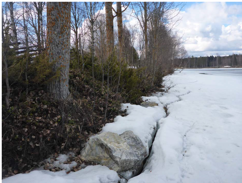
Figur 15. Exempel på erosionsskyddande block utlagda på utsatta områden i Umeälven. Brottkanten på isen flyttas ut utanför stenarna och på så sätt skyddas strandbanken från isnötning. Foto Åsa Widén.
