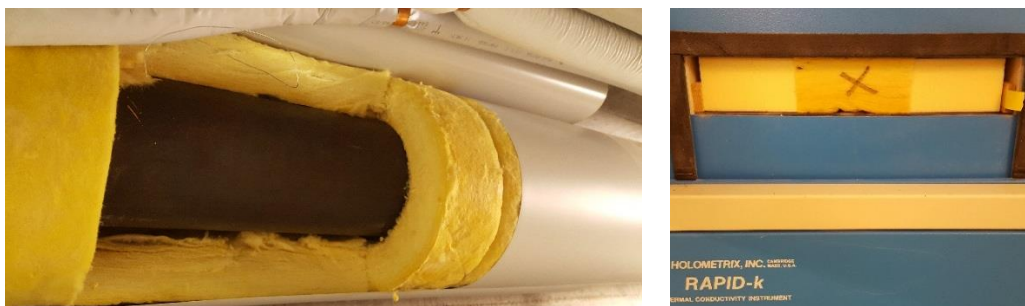
Figur 5. Bilden till vänster visar röret med den borttagna isoleringsbiten. Bilden till höger visar delar av den borttagna isoleringen när den testas med guarded hot plate-metoden.
