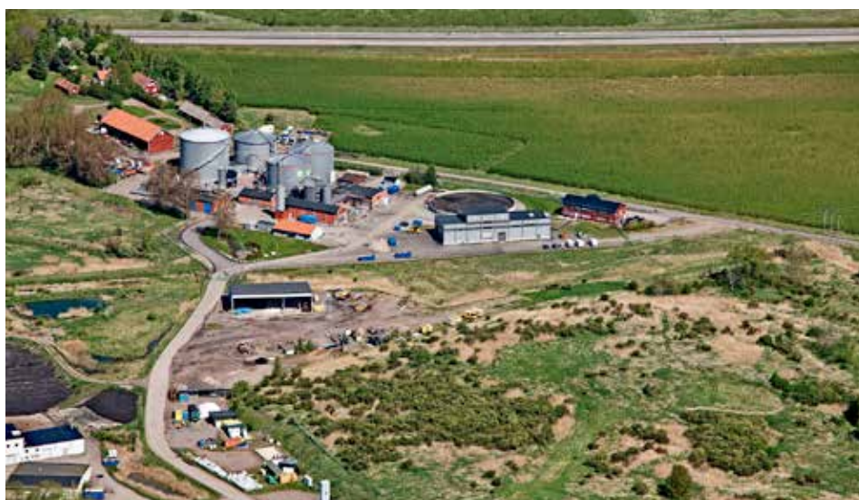
Biogasanläggning med samrötning. Foto: Biogasportalen
