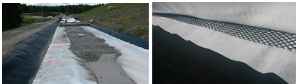
Figur 7 Tättskiktsduk (svart) och dräneringsmatta bestående av två lager geotekstil (vit) med plastnät (svart) mellan
