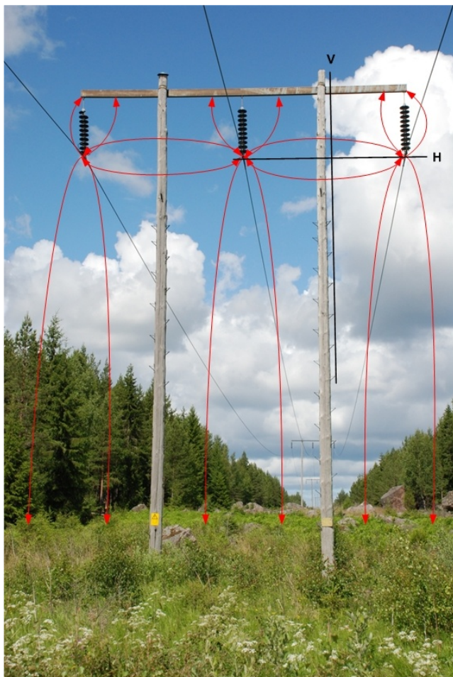
Figur 3. Äldre ledning för 130 kV med schematiska linjer för E-fältet i rött och med svarta linjer för fältberäkning längs stolpen (V) och i nivå med faslinorna (H).
