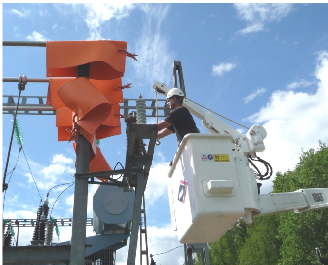
Figur 12. Arbete med isolerande dukar. Foto från Stefan Nilsson vid ELTEL Networks Infranet AB.
