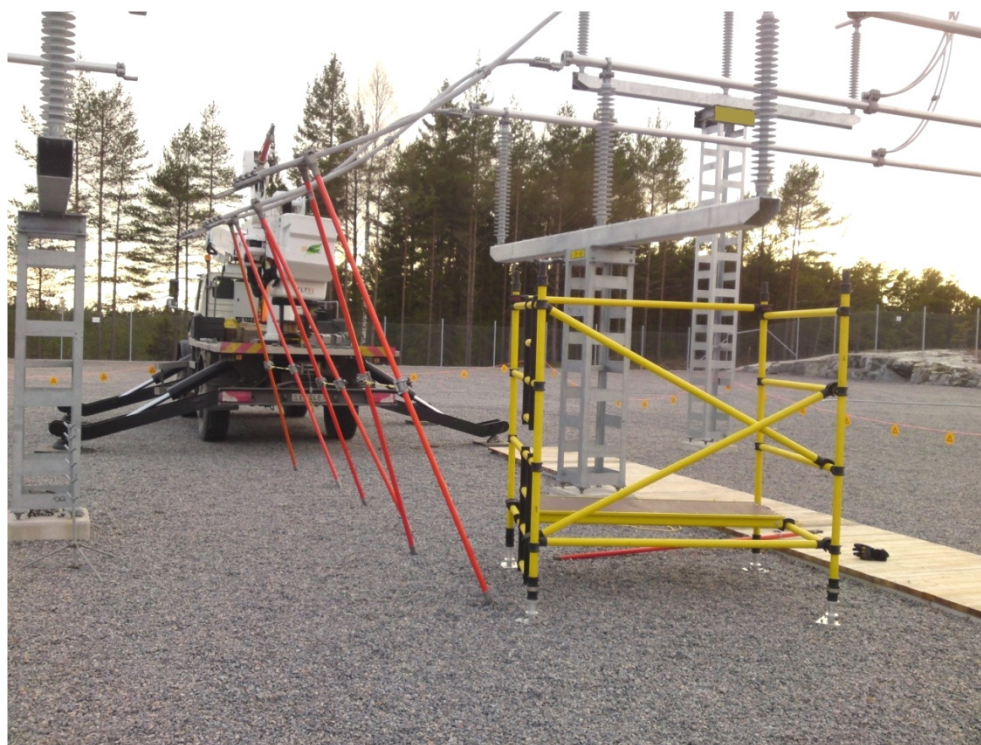
Figur 33. Isolerstänger används för att hålla upp faslinorna och arbetet kommer sedan att utföras från en isolerande ställning. Foto från Stefan Nilsson vid ELTEL Networks Infranet AB.
