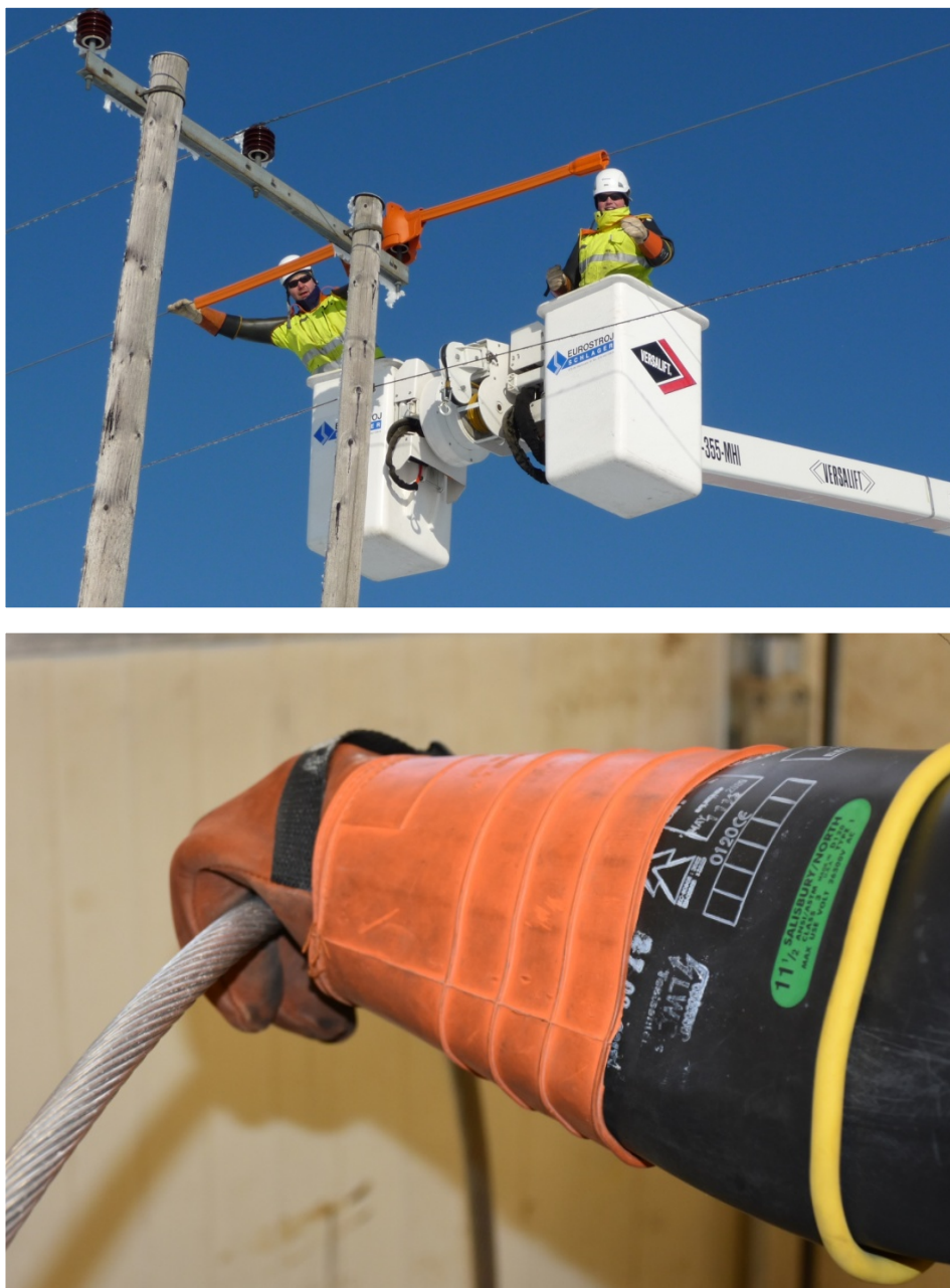
Figur 8. Isolerande handskar med yttre skyddshandske för Arbeta Med Spänning. Bilden överst visar hur man med handskar monterat isolerande skydd för lina och isolator och nedan visas en handske av denna typ med yttre skyddshandske. Det övre fotot är från Stefan Nilsson vid ELTEL Networks Infranet AB.
