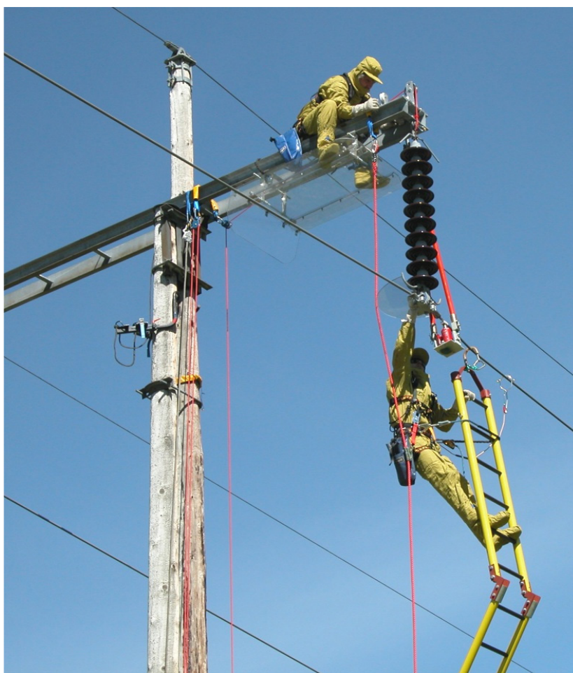
Figur 15. Montörer från Eltel Networks demonstrerar isolatorbyte med barhandsmetoden på en ledning för 132 kV i Norge. Båda montörerna bär ledande dräkt.
