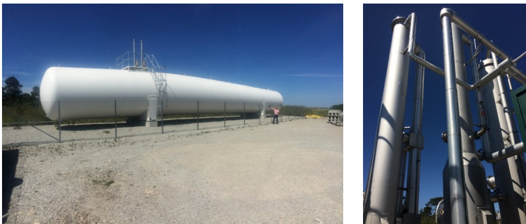
Figur 9 T.V. Befintligt lågtryckslager av gas vid Lundbygatans anläggning. T.H. skrubberkolonnen i Visby
