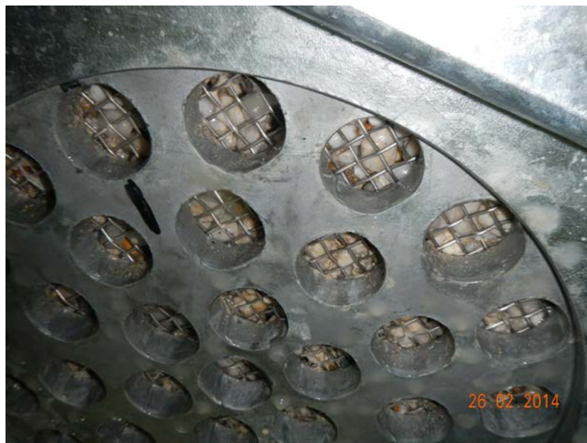
Fig. 2: Foto av underdel med utloppsplatta med nätfilter och delvis hålgjord platta (foto daterat 2014-02-26 i samband med platsbesök).
