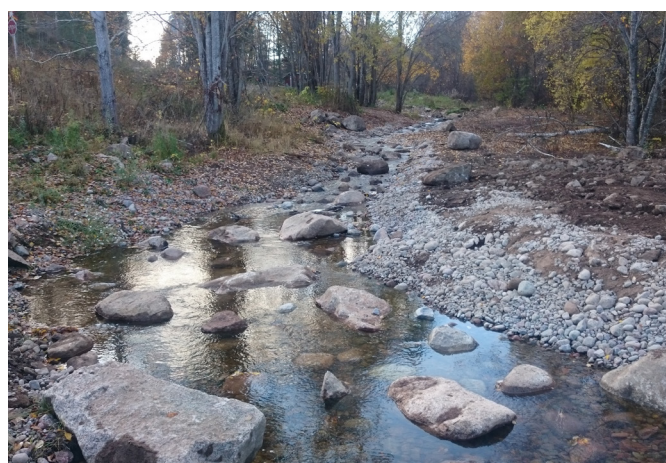
Utskovet vid snickeridammen är färdigsällt och den nya bäckfåran har schaktats ut och klätts med stenmaterial. Lillån (Emån) vid Kvillsfors, Vetlanda.
