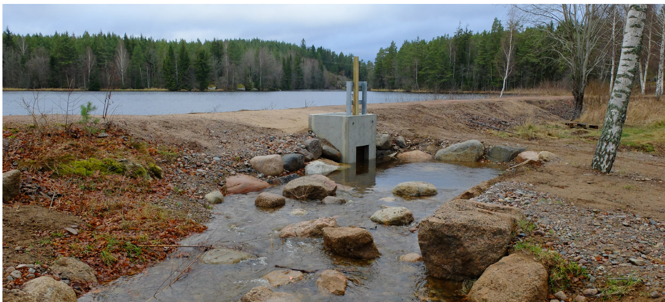
Utskovet från Tureforsdammen är på plats och provtappning i den nya faunapassagen pågår. Lillån (Emån) vid Kvillsfors, Vetlanda.
