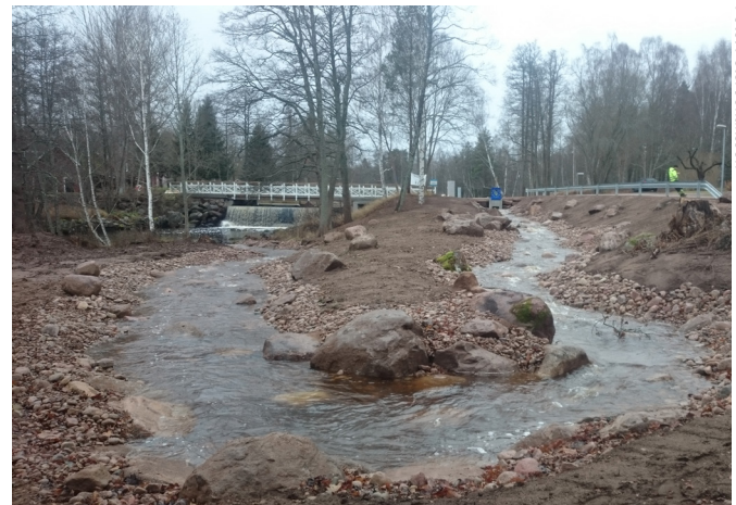
Brusaåan, biflöde till Emån, Mariannelund vid Herrgårdsdammen. Den nya bäckfåran i faunapassagen i väntan på vatten. Fåran har anlagts med stenmaterial i blandade fraktioner.
