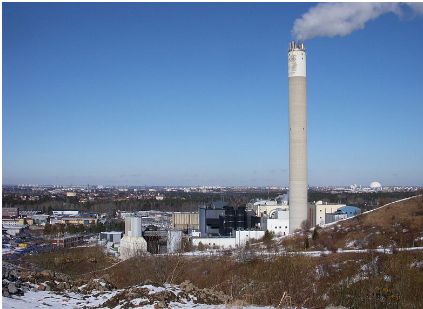
Figur 1. Bild över panna P6 vid Högdalenverket
