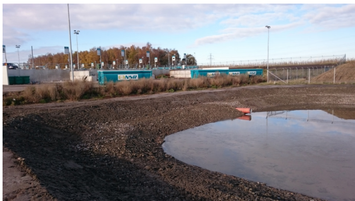
Figur 22 Utjämningsdamm för samlad avrinning från ÅVC. Inloppet utgör provpunkt ÅV2 i kontrollprogrammet.
