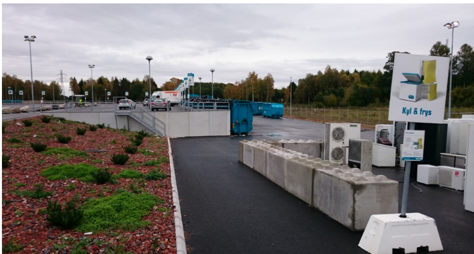
Figur 7 Del av ÅVC. Slaggrus har utnyttjats under asfalten, både på den lägre och på den högre nivån inom anläggningen, däremot inte inom vegetationsytor, där förstärkningslagret utgörs av makadam.
