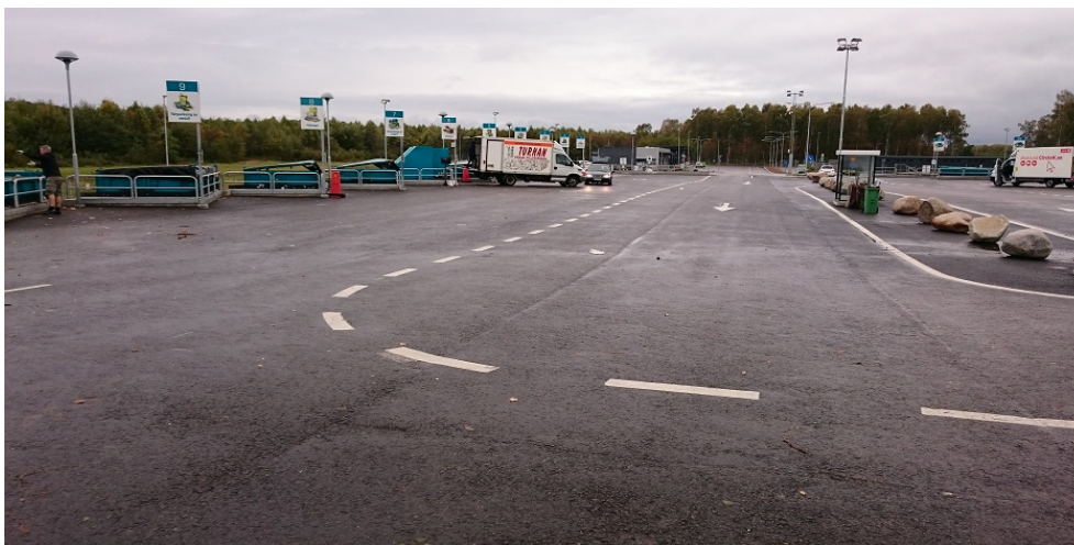
Figur 46. ÅVC Helsingborg – en försöksyta för fortsatt uppföljning av slaggrusanvändning i markbyggnader
