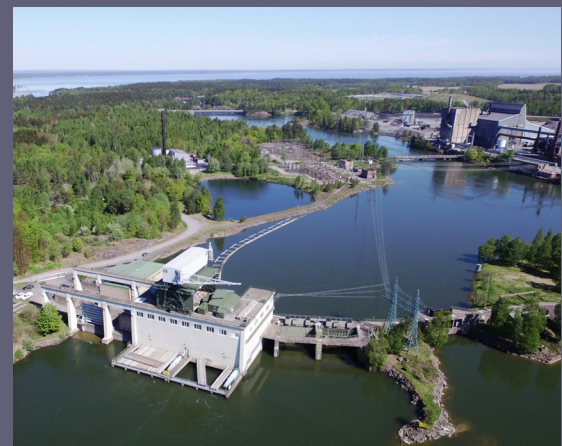
Kraftverk i Göta älv. Foto: Norconsult
