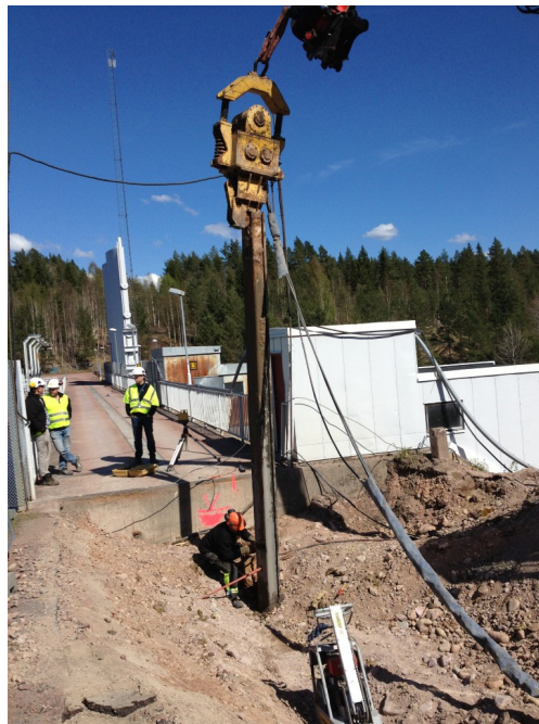
Figur 3.9 - 4 Foderröret monterat och hålls fast av oscillatorn. Kranen förbereder nedsänkning av mejsel i foderrör. Till höger dragning av flytande spont i tättkärnan närmast betongkonstruktionerna.
