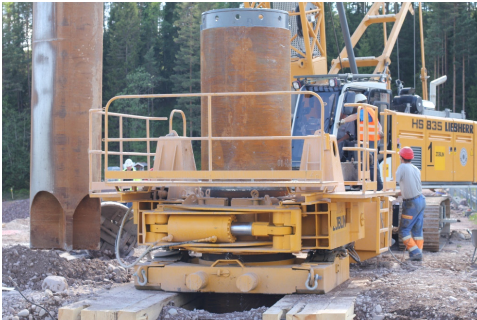
Figur 3.9 - 3 Foderrör under neddrivning. Oscillatorn vilar på träbjälkar för att inte skada de gjutna styrbalkarna. Till vänster syns mejseln som lyfts.
