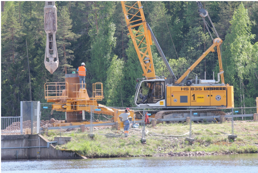
Figur 3.9 - 2 Gripskopen lyfts. Till vänster syns material som tagits upp ur foderröret med gripskopen.
