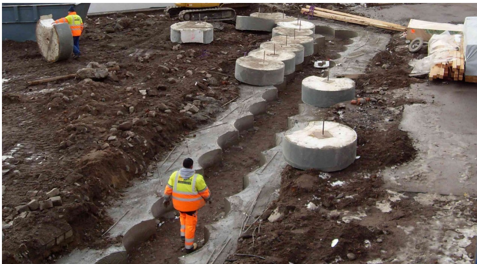
Figur 2.1 - 1 Typexempel på färdiggjuten styrbalk. Frigolitblocken utgör form för genomföringarna för sekantpålarna.
