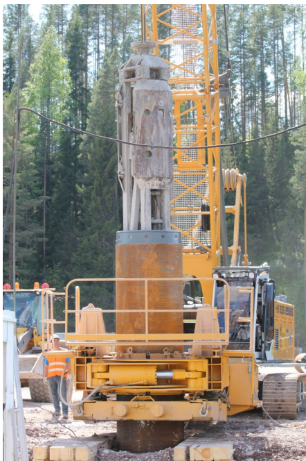
Figur 3.9 - 4 Foderröret monterat och hålls fast av oscillatorn. Kranen förbereder nedsänkning av mejsel i foderrör. Till höger dragning av flytande spont i tättkärnan närmast betongkonstruktionerna.
