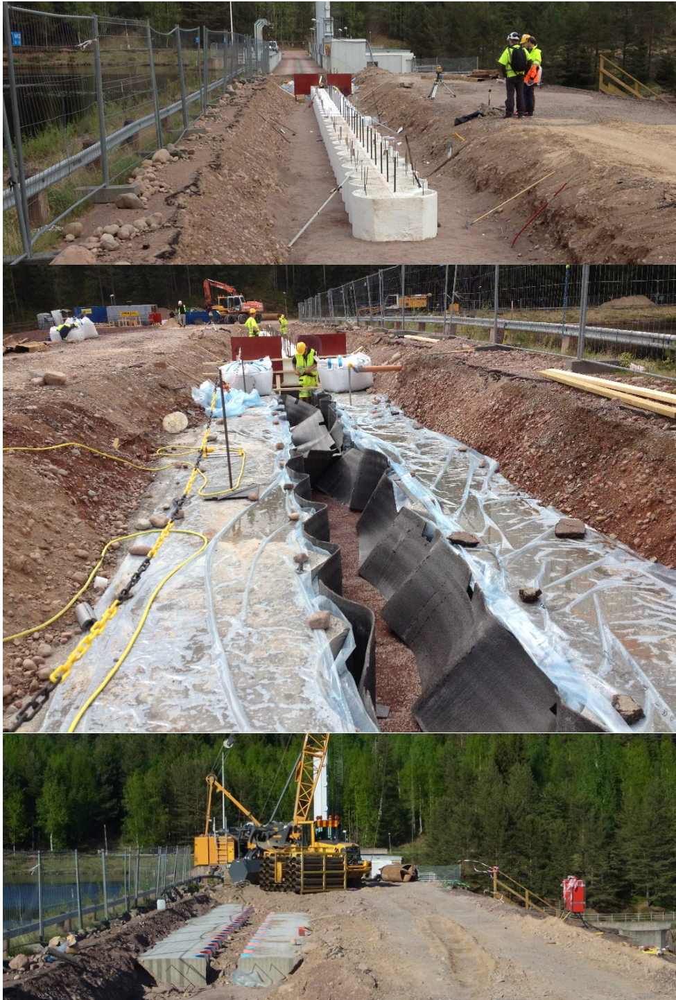
Figur 3.9 - 1 Första etappen styrbalkar. Överst syns frigolitblocken fixerade, markerande lägena för sekantpålarna. Under, styrbalkarna gjutna och frigolitblocken borttagna. Delen närmast utskovskonstruktionen utfördes i ett senare skede.
