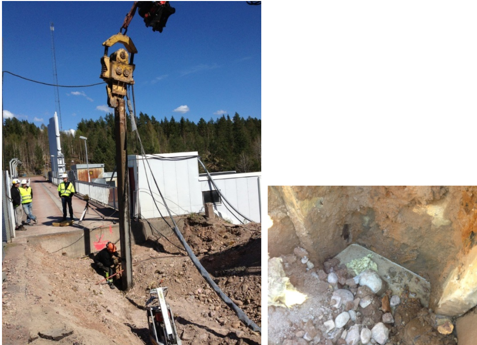
Figur 3.9 - 6 Dragning av spontplanka. Till höger lokal flytning i tätkärna kring dragen spont pga. vibrationer. Rester från trasig markisolering kan ses invid spontplankan.
