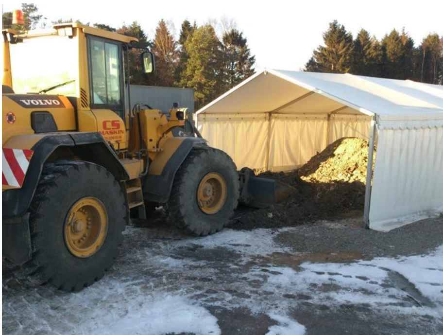
Figur 5. Omblandning av slagghög H3.
