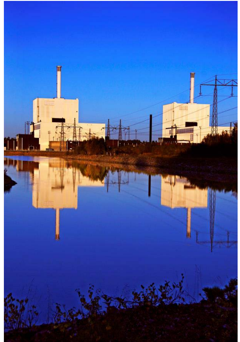
Forsmark, NPP, picture from Vattenfall
