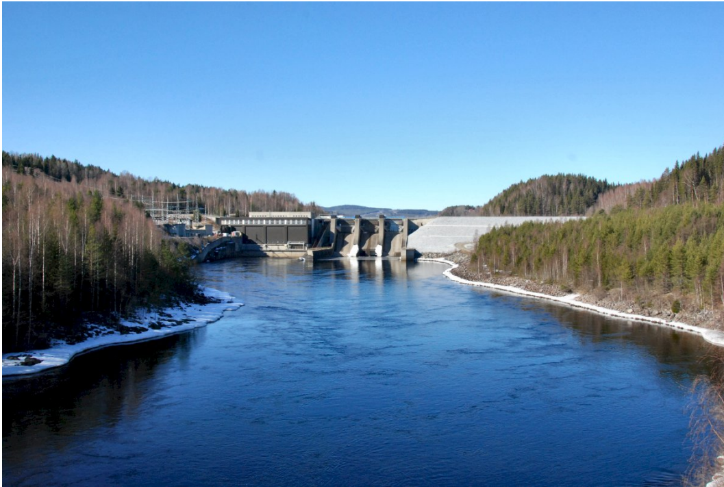
Figur 5: Moforsens kraftverk i Ångermanälven var i centrum för den första pilotövningen. Foto: VSL Systems AB.
