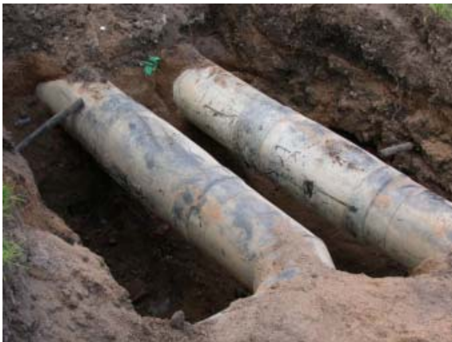
Figur 4.14 Frilagda skarvar vid Marklandsgatan. Excavated joints at Marklandsgatan.
