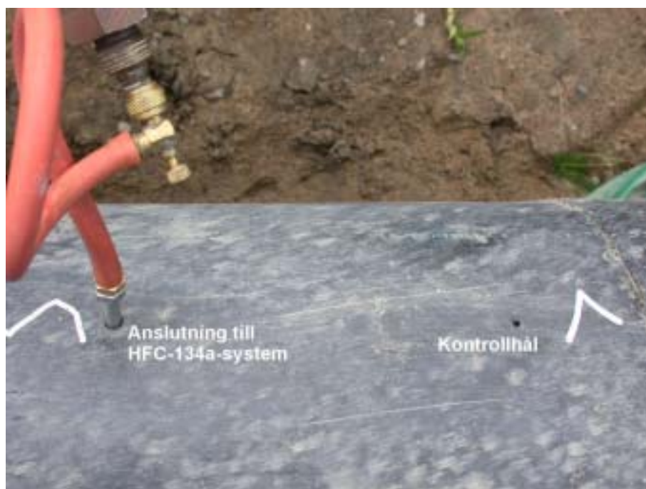
Figur 3.1 Täthetskontroll av skarvhylsa. Tightness test of joint casing.
