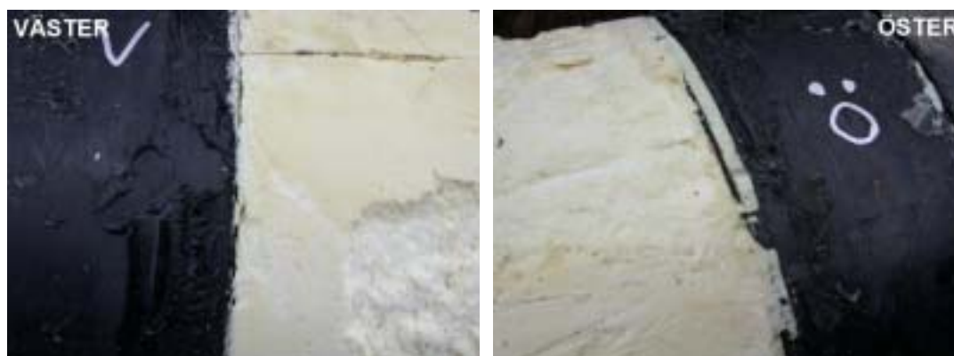
Figur 4.16 Anslutningar mellan skarvisolering och rörändar på framledning vid Marklandsgatan. Interfaces between joint insulation and pipe ends on flow pipe at Marklandsgatan.
