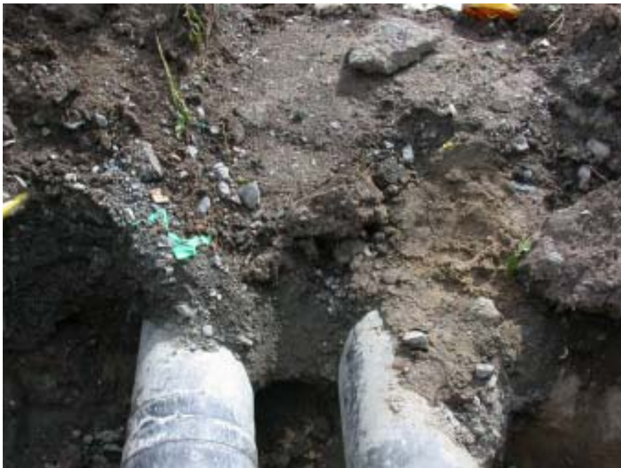
Figur 4.3 Snitt genom fyllningsmaterial vid Gustaf Melins gata. Section through backfill at Gustaf Melins gata.
