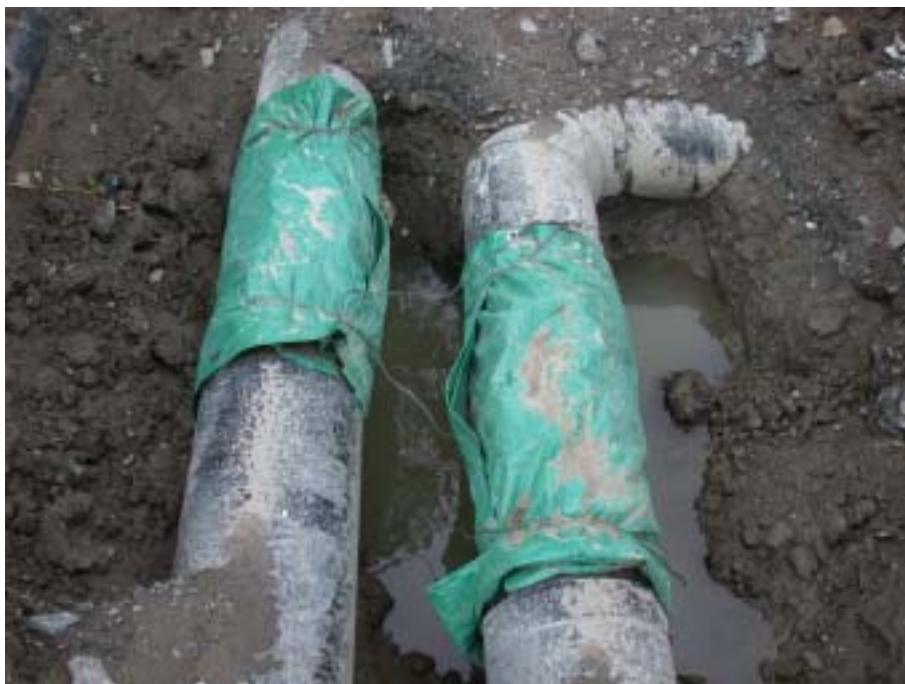
Figur 4.5 Vatten i schakt vid Gustaf Melins gata. Water in trench at Gustaf Melins gata.
