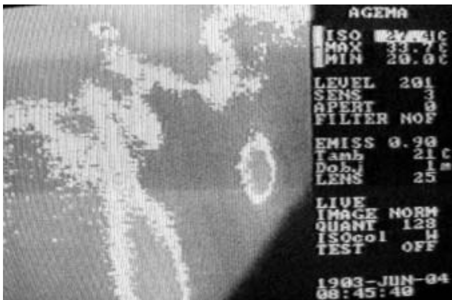
Figur 4.7 Termogram över skarven på framledningen vid Gustaf Melins gata. Thermogram of the flow pipe joint on Gustaf Melins gata.
