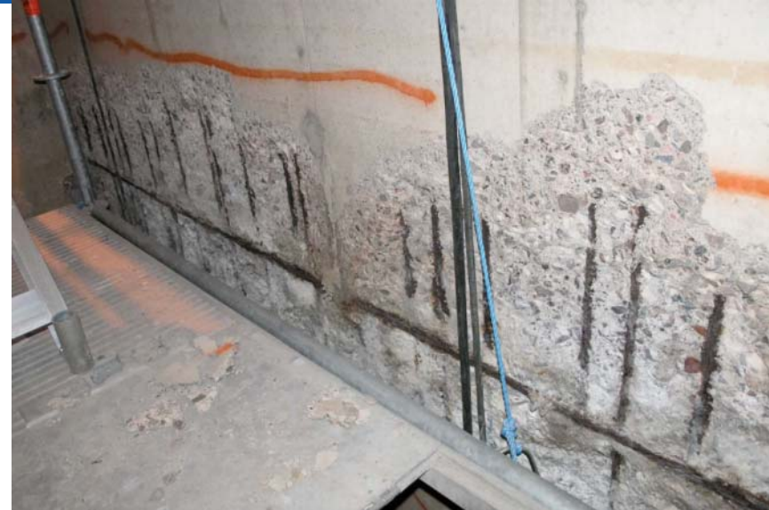
Handbilning av lös betong
