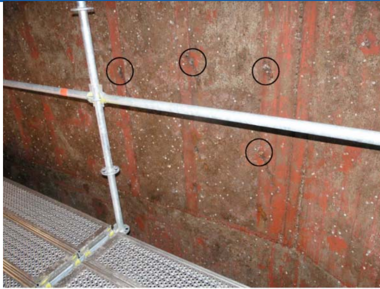
Rostutfällningar som troligen härrör från formstag
