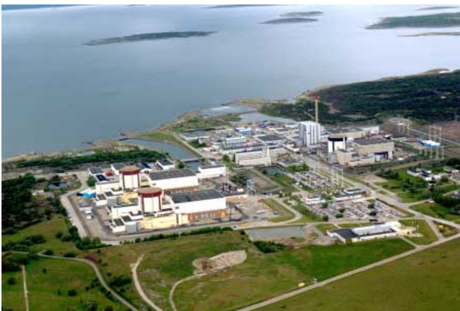
Bild 1.2. Ringhalsverket. Foto genom Ringhals AB.
