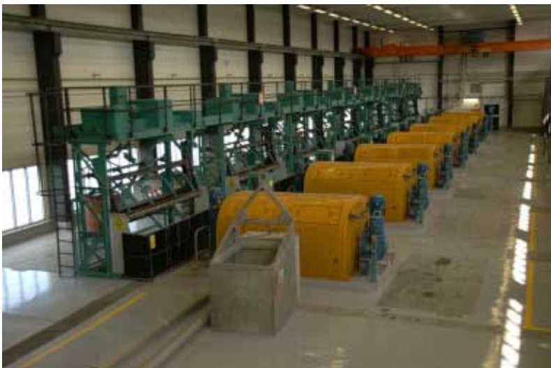
Bild 6.2. Silstation vid Forsmarksverket. Foto genom Forsmarks Kraftgrupp AB.
