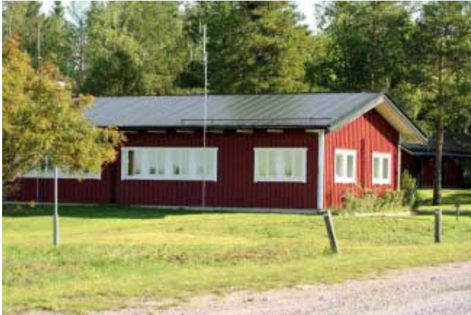
Bild 3.4. Vid Biotestanläggningen uppfördes ett laboratorium, Biotest-laboratoriet. Foto: B. Nyman.
