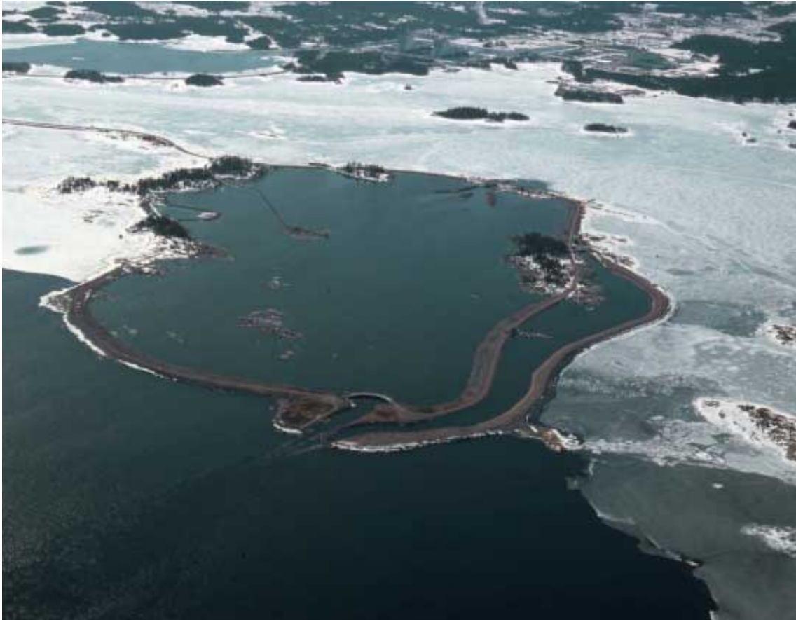
Bild4.2. Biotestsjön vid Forsmark med utlopp av kylvatten från F1 och F2 samt till höger därom kylvattenkanalen från F3. Foto genom Forsmarks Kraftgrup AB.
