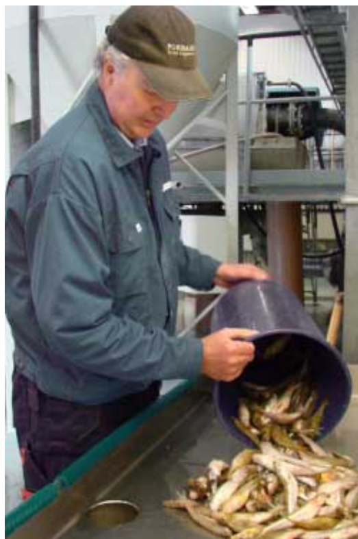
Bild 6.4. Fisk som fastnat i silstationen vid Forsmarksverket. Foto genom Forsmarks Kraftgrupp AB.
