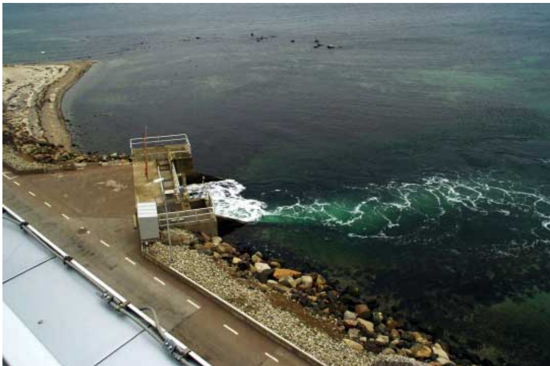
Bild 4.4. Barsebäckskraftverkets kylvattenutsläpp. Foto: S. Lindahl.
