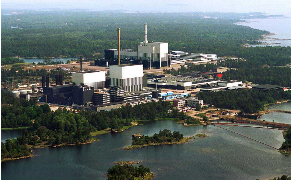
Figur 2.8. Oskarshamnsverket. Kylvattenintagen till O1 och O2 är placerade i strandkanten. Foto genom OKG AB.
