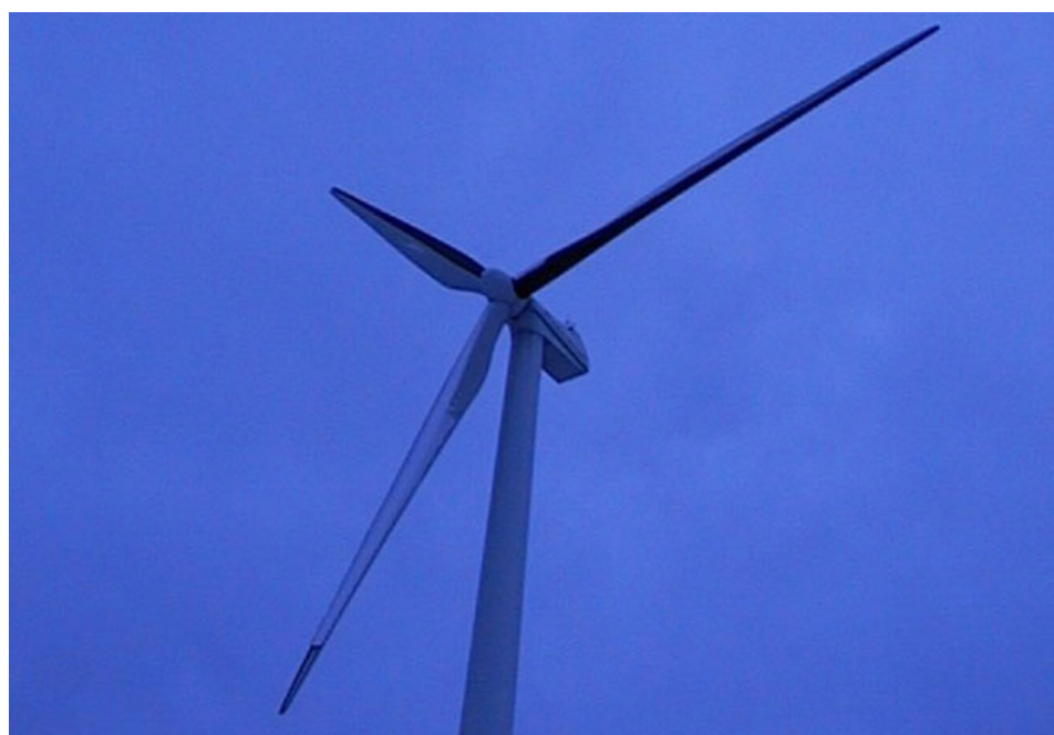
Figur 33. Hunflen 2003-01-07. Verket har nu varit avställt i 6 veckor p.g.a. av nedisade blad. Lägg märke till att den svarta bladframkanten, kanske tack vare parkering med rotorn i söderläge, är fri från is. Aerodynamiken är ändå så pass störd att aggregatet inte förmår uppnå för drift erforderligt moment och varvtal. Det skulle dröja ytterligare en vecka innan aggregatet kunde tas i drift. Foto: Kjell Jansson, Malungs Elnät AB.
