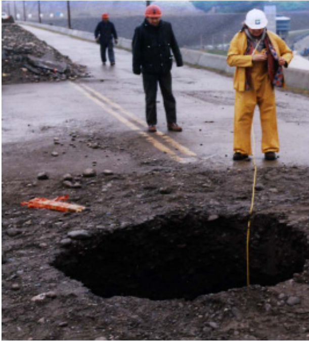
Figur 3-12. Sjungrop på dammkrönet av Bennet Dam, Kanada. Bild från Steve Garner (2006).
