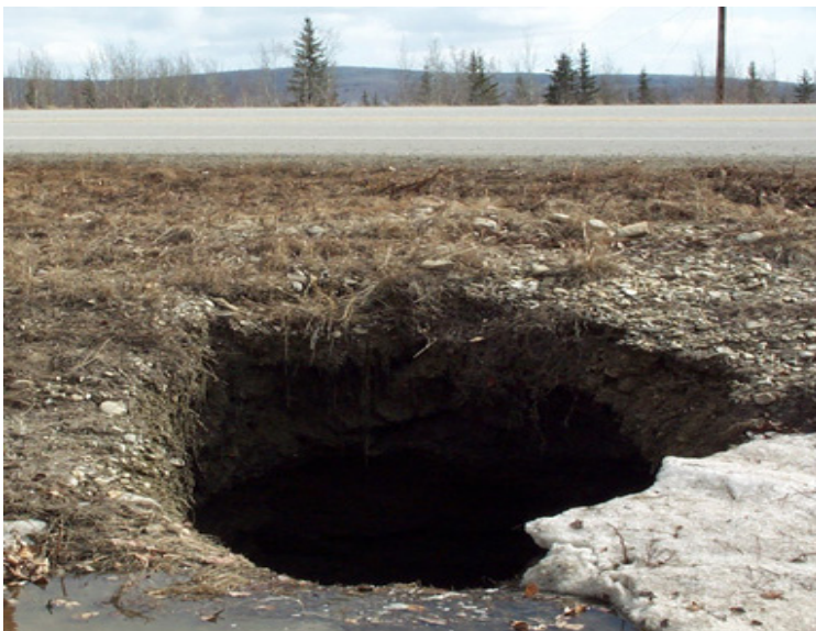
Figur 3-5. En typisk sjunkgrop. När material förs bort underifrån på grund av erosionen ersätts det förlorade materialet uppifrån varför områden sjunker ner i dammkroppen. Bild från The National Center for Atmospheric Research & the UCAR Office of Programs.
