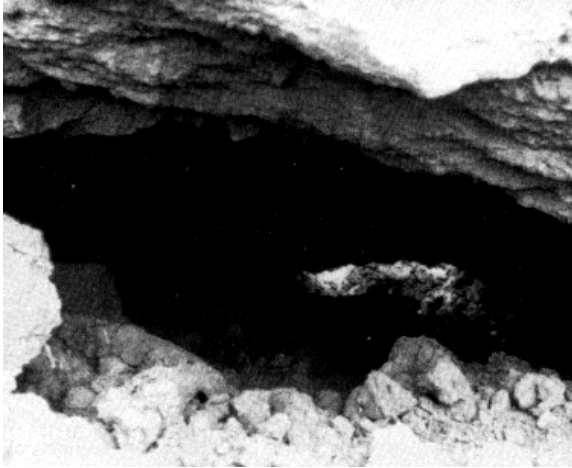
Figur 3-4. Klassisk bild på hur en pipingskada kan se ut. Skadan kan bäst liknas vid grottbildning där taket hålls upp av de starka kohesiva krafterna som råder i tätjärnans jord. Vattenfall (1988).
