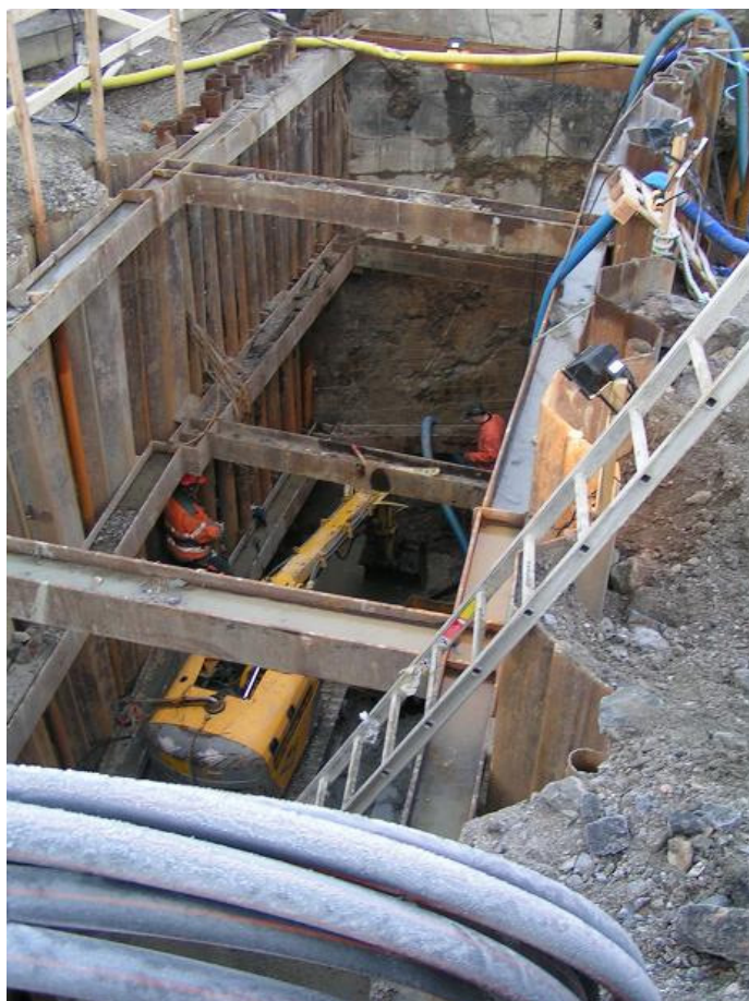
Figur 6-2. Utgrävning av tät kärnan vid Lilla Edet. Vid bakre delen av bilden syns betongkonstruktion som utgör en del av sluss i Göta Älv som går genom dammen. Bild Johan Lagerlund
