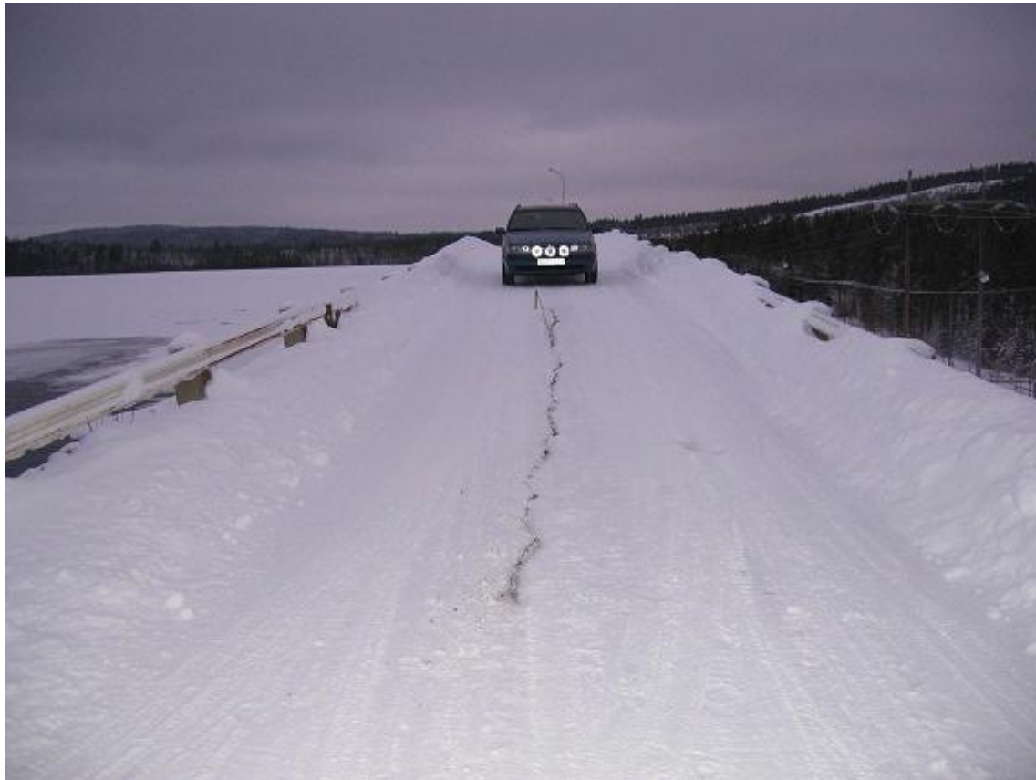
Figur 3-10. längsgående spricka på dammkrön liknande SPRICKFALL TVÅ eller SPRICKFALL FYRA . Bild Åke Nilsson.
