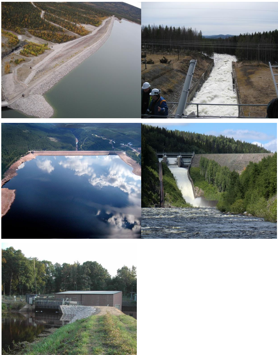
Figur 3. Flygbild över Seitevare-dammen med Tjaktjajaure-magasinet nästan uppe vid dämningssgräns (överst till vänster, copyright Vattenfall, fotograf Jennie Nilede), utskov i Torpshammar med pågående spill (överst till höger, copyright Vattenfall, fotograf Erik Nordström), flygbild över Trängslet-dammen (mitten till vänster, copyright Fortum, fotograf Stefan Sjödin), Höljesdammen med pågående spill (mitten till höger) och dammlucka i Torsebro (nederst, copyright E.ON).
