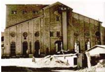
Figur 1. Slite gamla kraftstation.
