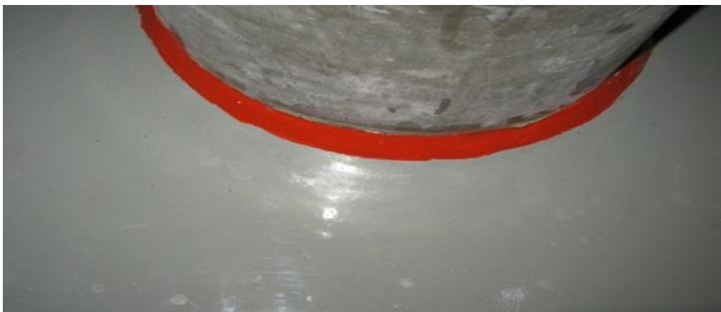
Figur 2-4 Silikontätning avsedd för höga temperaturer, här i reaktorinneslutning hos OKG.
