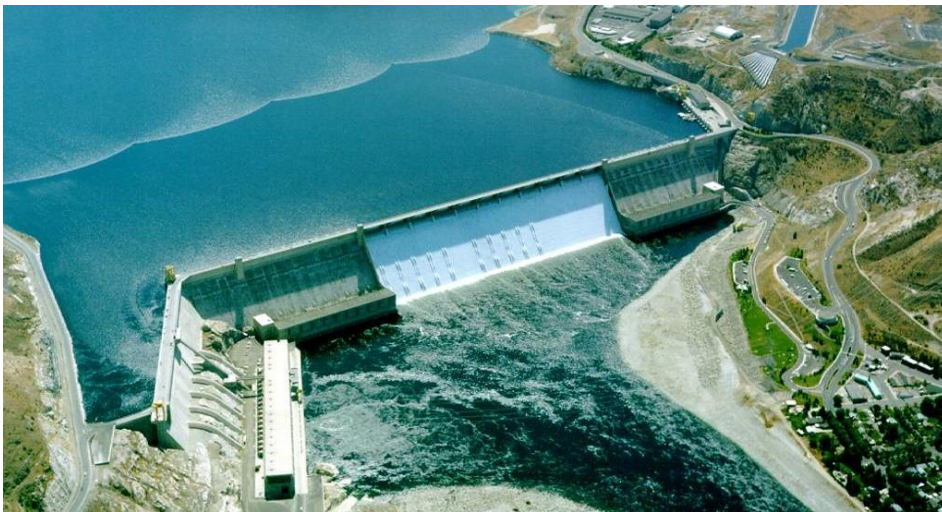
Figur 2-1 Exempel på en massivdamm Grand Coulee Dam, från https://sv.wikipedia.org/wiki/Grand_Coulee-dammen
