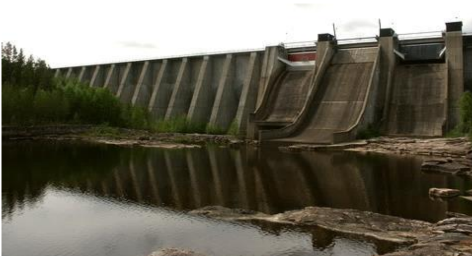
Figur 2-2 Exempel på en betonglamelldamm, Rätan, från https://vattenkraft.info/?id=425 .
