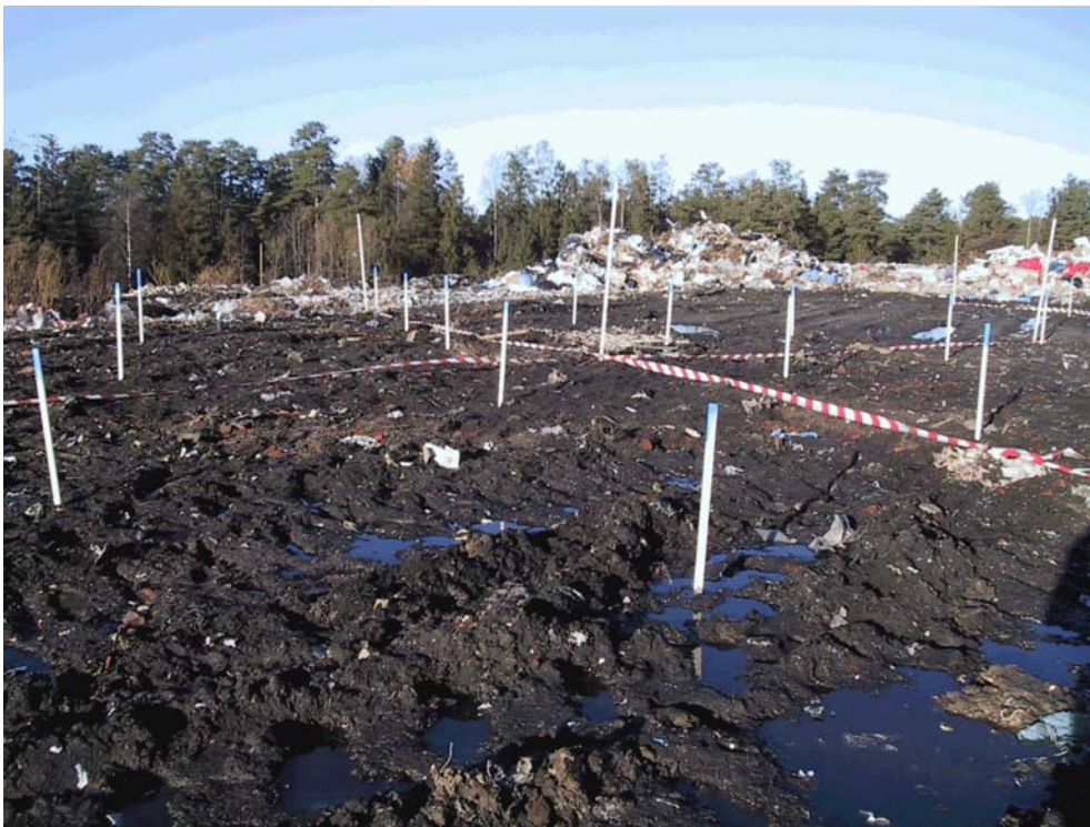
Figur 37. Markeringar på injekteringsytan på deponin för borrning och injektering.
