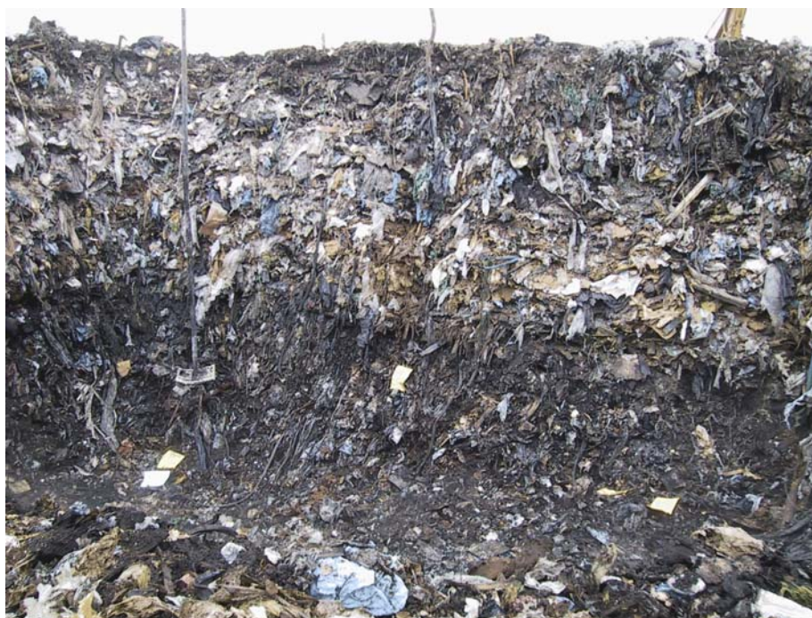
Figur 61. Utgrävt schakt framför hål 3, 4 och 15 ner till 5,5-6 meters djup.
