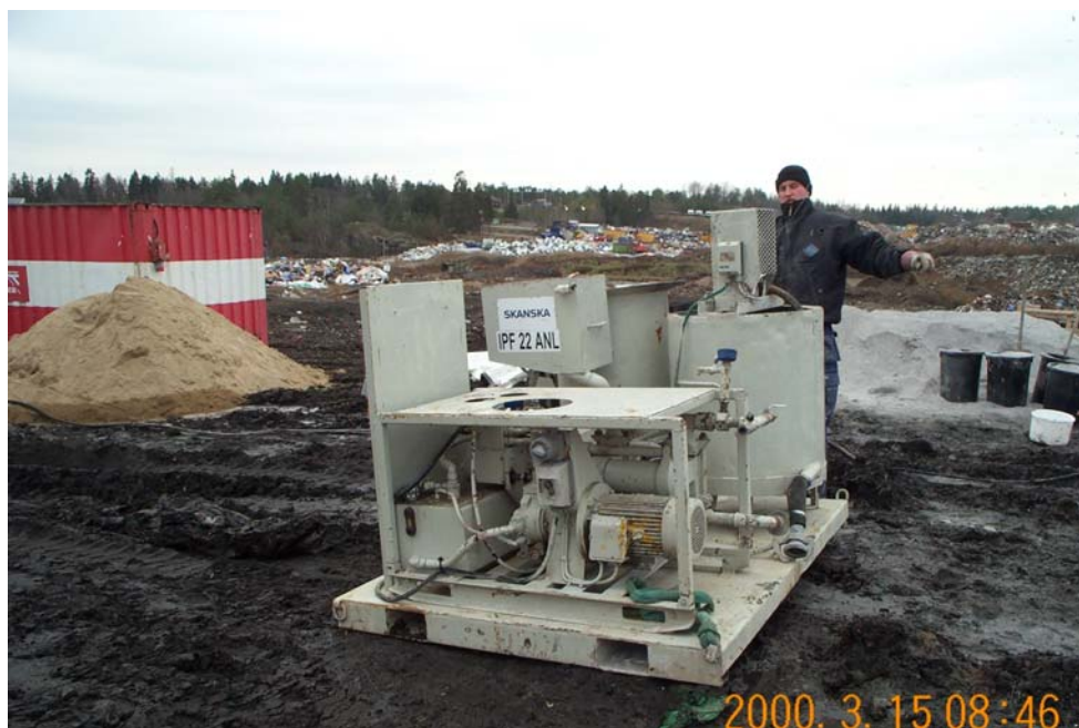
Figur 12. Utrustningen för cirka 150 liter som användes under större delen av injekteringsarbetet (pumpplattform Willis).
