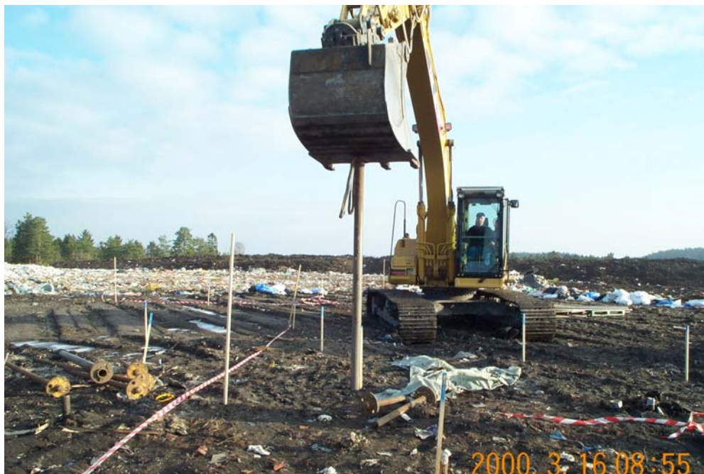
Figur 38. Nedtryckning av perforerade stålrör i deponin med hjälp av en grävmaskin.
