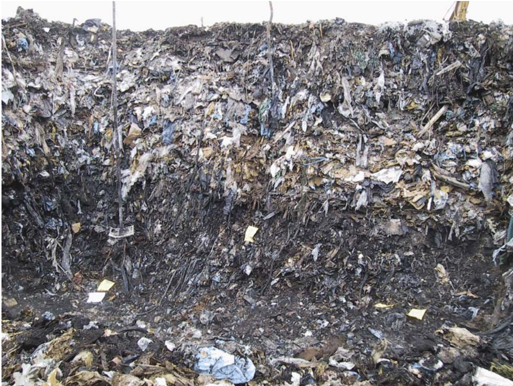
Figur 23. Deponin i genomskärning ner till 6 meters djup. Innehållet i deponin är en blandning av hushålls- och industriavfall. De översta metrarna består enbart av industriavfall.
