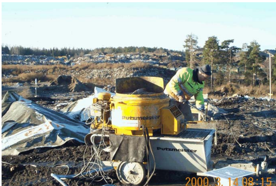
Figur 40. Liten utrustning för injektering som användes för injektering i ett hål under de två första injekteringsdagarna.
