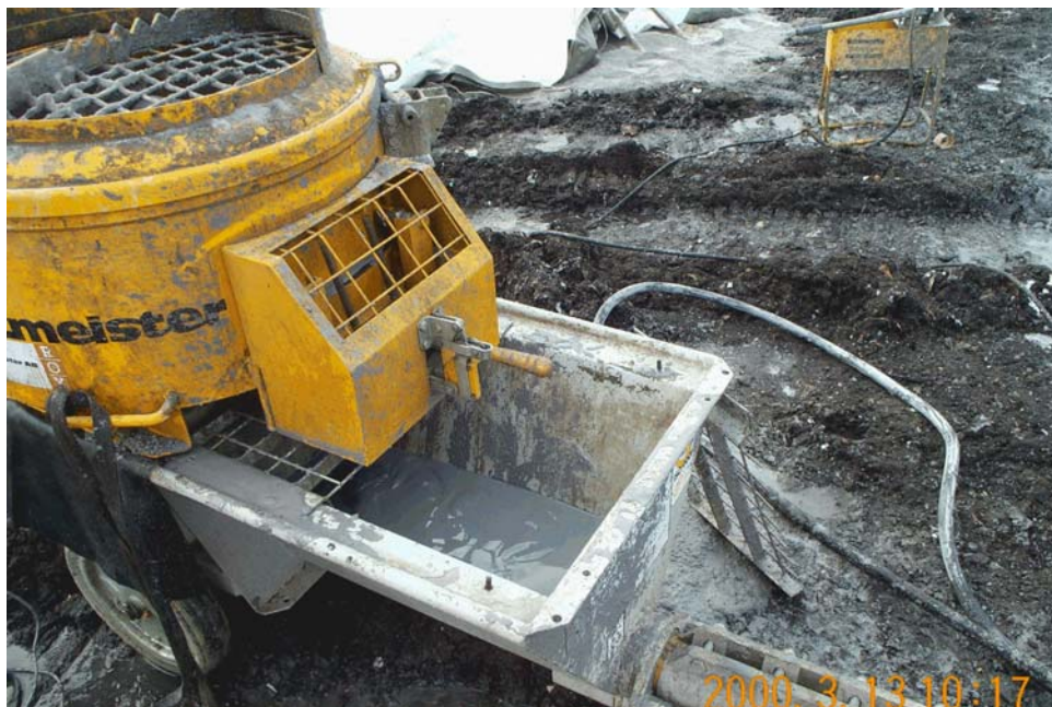
Figur 11. Utrustningen för cirka 80 liter som användes för injektering under de första injekteringsdagarna (Putzmeister S5 EV).
