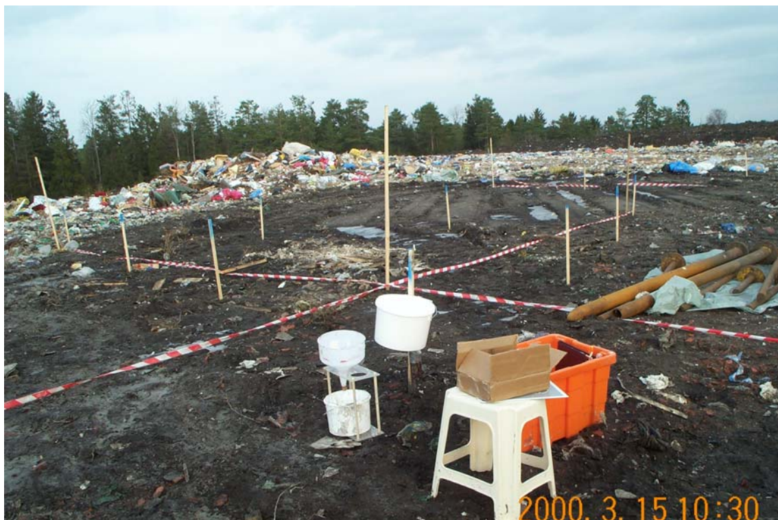
Figur 42. Försöksuppställning för trattförsök för test av flytegenskaperna under injekteringsarbetet.
