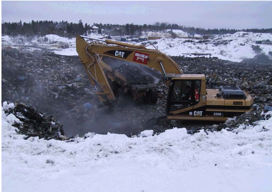
Figur 55. Grävmaskinen som användes för utgrävningen av det injekterade området på deponin.
