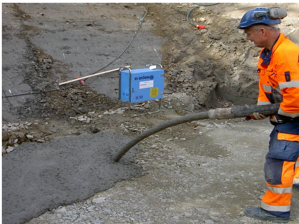
Figur 13. Betonggjutning med aska från Uppsala Värmeverk som fillermaterial
