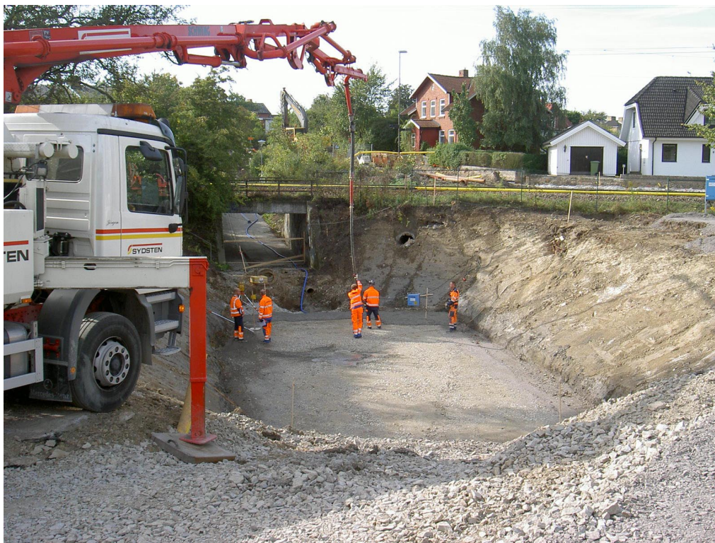
Figur 6. Skyddsbetong gjutning, Timjanvägen, Lund
