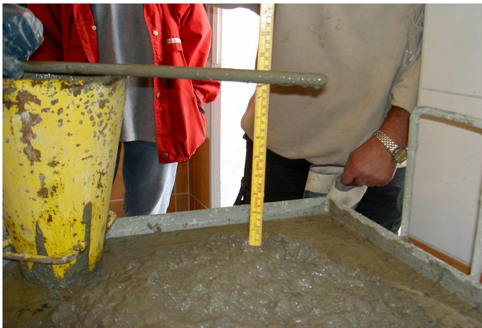
Figur 12. Sättkon på betongen med aska från Uppsala Värmeverk som fillermaterial
