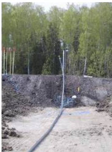
Figur 2.15 Installation av slang för slangställningsmätning, provyta 1.
