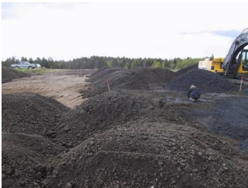
Figur A.2 Upplagt FSA-material i väntan på utläggning Figure A.2 FSA material before construction
