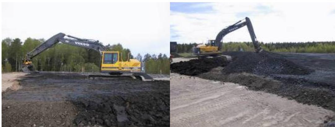
Figur 2.9 Utlagt FSA och dräneringssikt. Bild a är provyta 4 med sand som dräneringssikt och bild b är provyta 1-3 med slaggrus som dräneringssikt.
