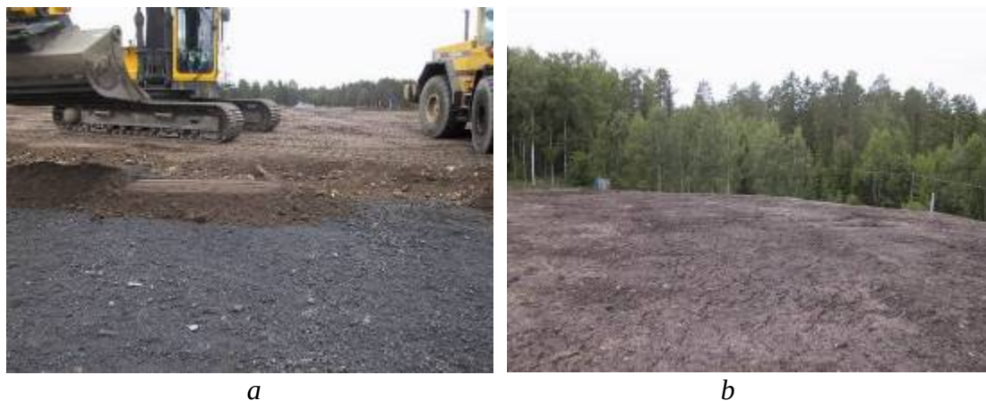
Figur 2.11 Skyddsskikt bestående av återvunna schaktmassor (0,5 m) och återvunnen jord (1 - 1,5 m) har lagts ut över dräneringsskiktet, utläggningsarbete av skyddsskiktet (vänster) och färdig deponiyta (höger).
