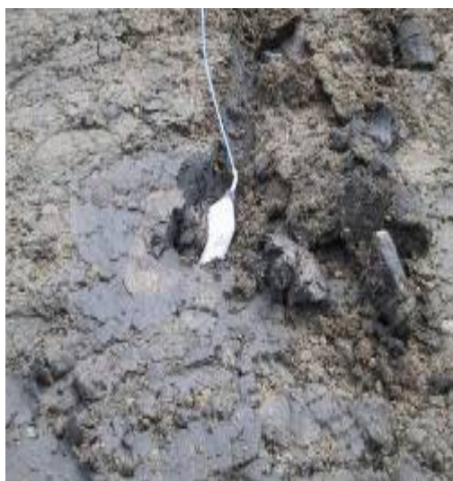
Figur 2.14 Installation av gaslysimeter i tätskiktet, provyta 4.
