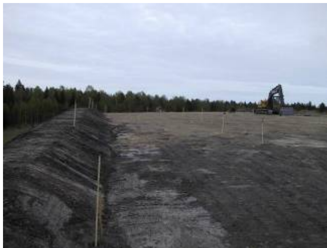
Figur 2.3 Avjämningskikt över hela provytan, med vallen installerad på norra sidan av provytan.
