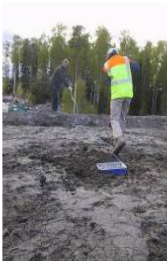
Figur 2.13 Installation av lysimetrar i avjämningsskiktet, provyta 4.
