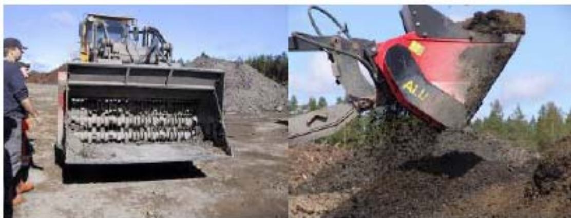
Figur 6. Förblandning av flygaska och avloppsslam med skopblandare [5].
