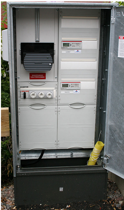
Figur 3.9 Kabelmätarskåp.
