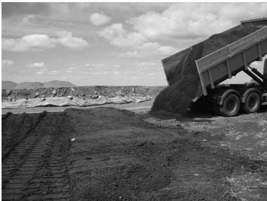
Figur 4-10. Utläggning av slam/aska-blandning vid SRV Återvinning, juni 2005.
