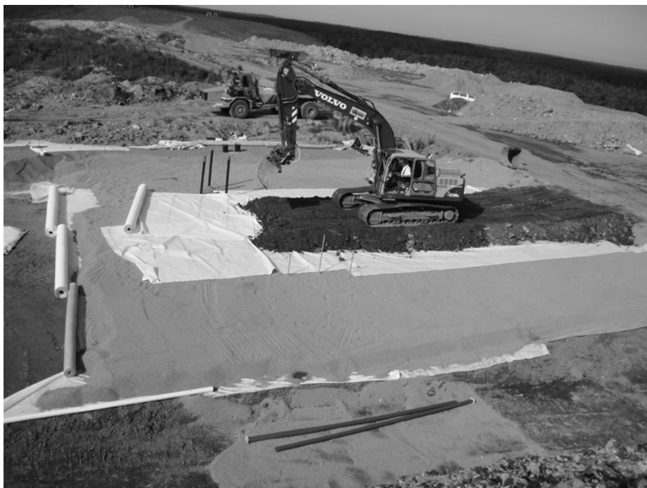
Figur 4-12. Utläggning av skyddsskikt på SRVs provyta.
