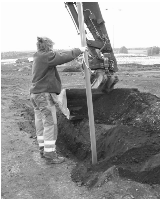
Figur A-7. Installation av skyddsror för gasprob.
