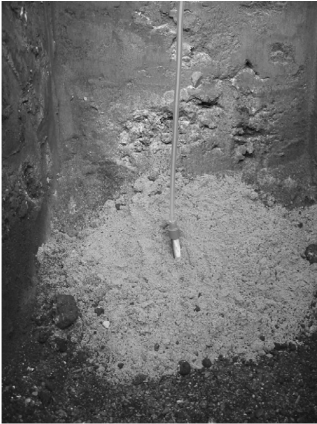
Figur A-6. Exempel på installation av gasprob.
