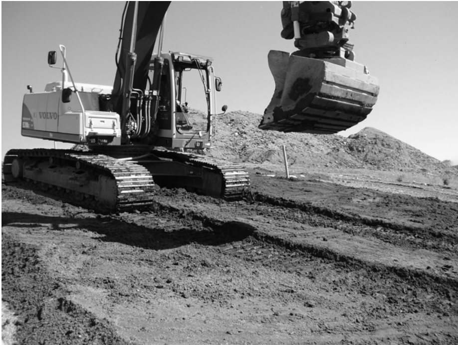
Figur 4-11. Packning av tätskiktet i slänt på SRV Återvinning.
