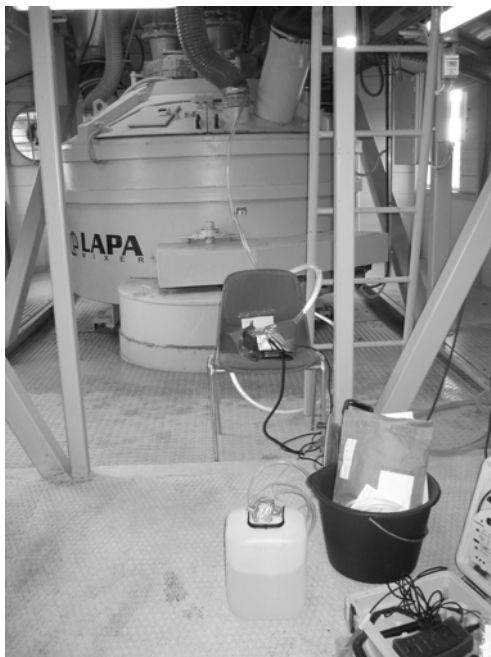
Figur 6-1. Försökuppställning. Blandningskammare för Monofill och RGR (rökgasreningsrest från avfallsförbränning). Luft sugas via en kompressor från ventilationskanal till blandaren. Luften tillåts sedan passera vatten i dunken i förgrunden.
