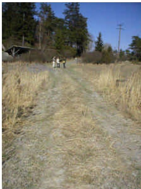
Figur 3.22 Typen av väg som renoverades med flygaskastabiliserat grus, Uppsala.
