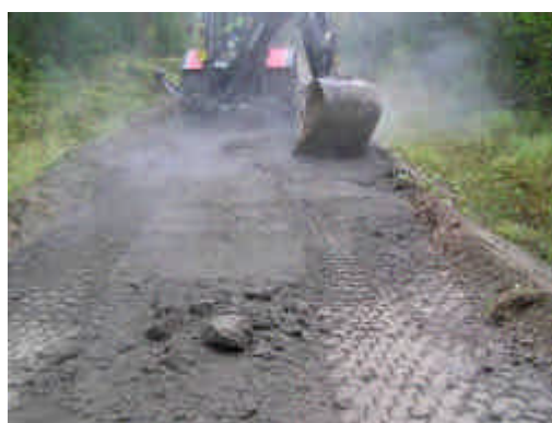
Figur 3.7 Flygaskan hann börja härda under transporten.
