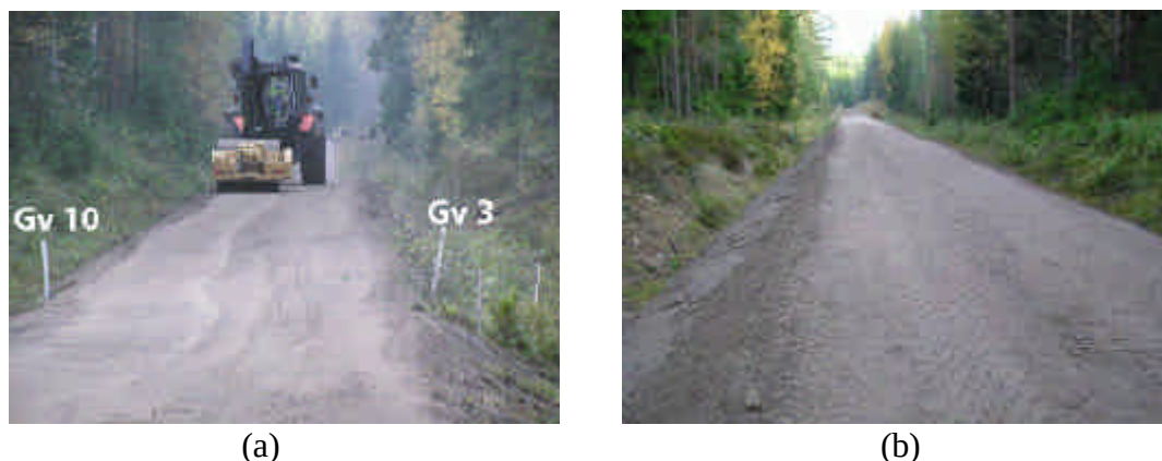
Figur 3.6 (a) Packning av den flygkastabiliserade vägen, med grundvattenrören, Gv 10 (vänster) Gv3 (höger) och (b) den färdiga vägen med utlagt slitlager.
